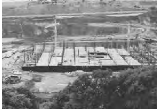
Figura 3. Muestra la construcción de una tienda, desde la cimentación.
