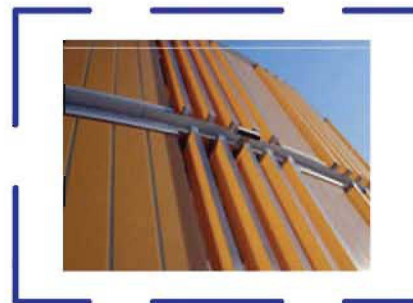
Doble fachada con louvers de vidrio tintado
