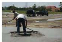
Concreto: Muros interiores
