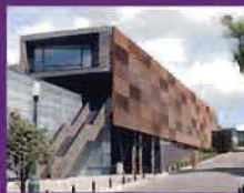
Doble fachada con lámina perforada
