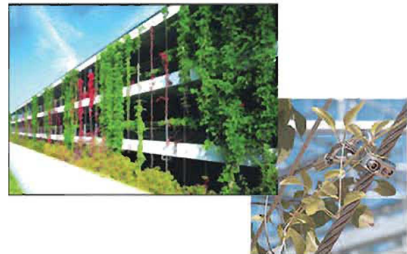
Sistema de cables tensados
