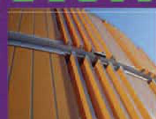
Doble fachada con louvers de vidrio tintado
