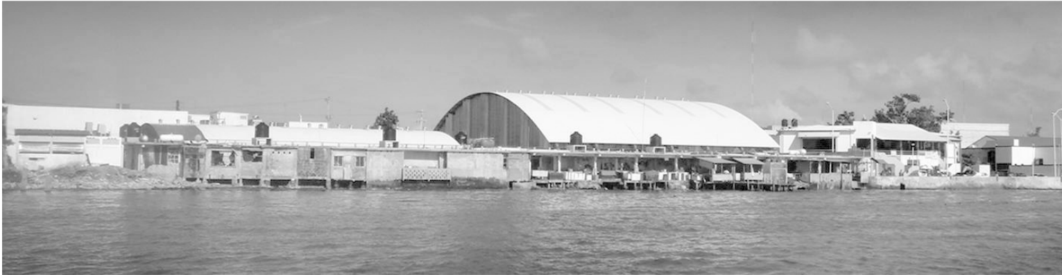
IM-19. Imagen del deterioro del malecón norte en Ciudad del Carmen.
