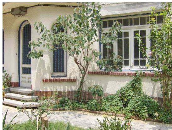
Ventanas de las zonas de estar de las casas unifamiliares de las privadas del Conjunto Isabel de Juan Segura con vista a los patios colectivos.
