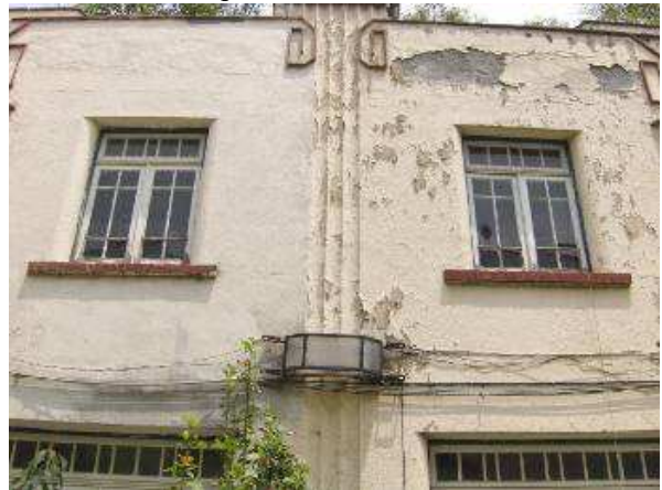
Detalles de remates y diseños de iluminación originales en la zona de casas unifamiliares. Privada Norte. Imagen: CON
