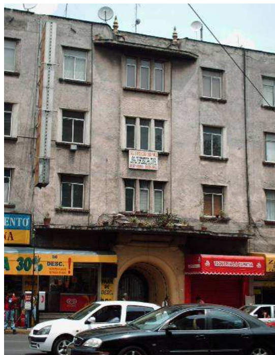
Marquesinas de concreto armado sobre las puertas principales del Conjunto Isabel. Imagen: CON
