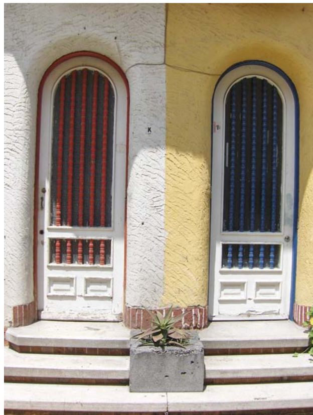
Puertas y ventanas de las casas unifamiliares de las privadas del Conjunto Isabel de Juan Segura 1929. Imagen: CON
