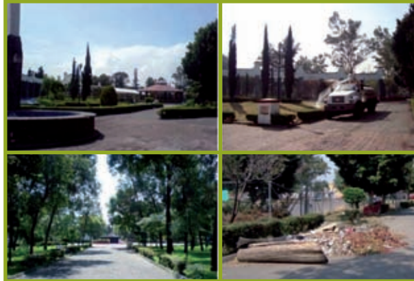
Fig. 30. Parte de arriba y abajo a la izquierda, zona de kiosco y plaza donde se procura el mantenimiento de la vegetación. Abajo a la derecha, sendero obstruido por basura.
