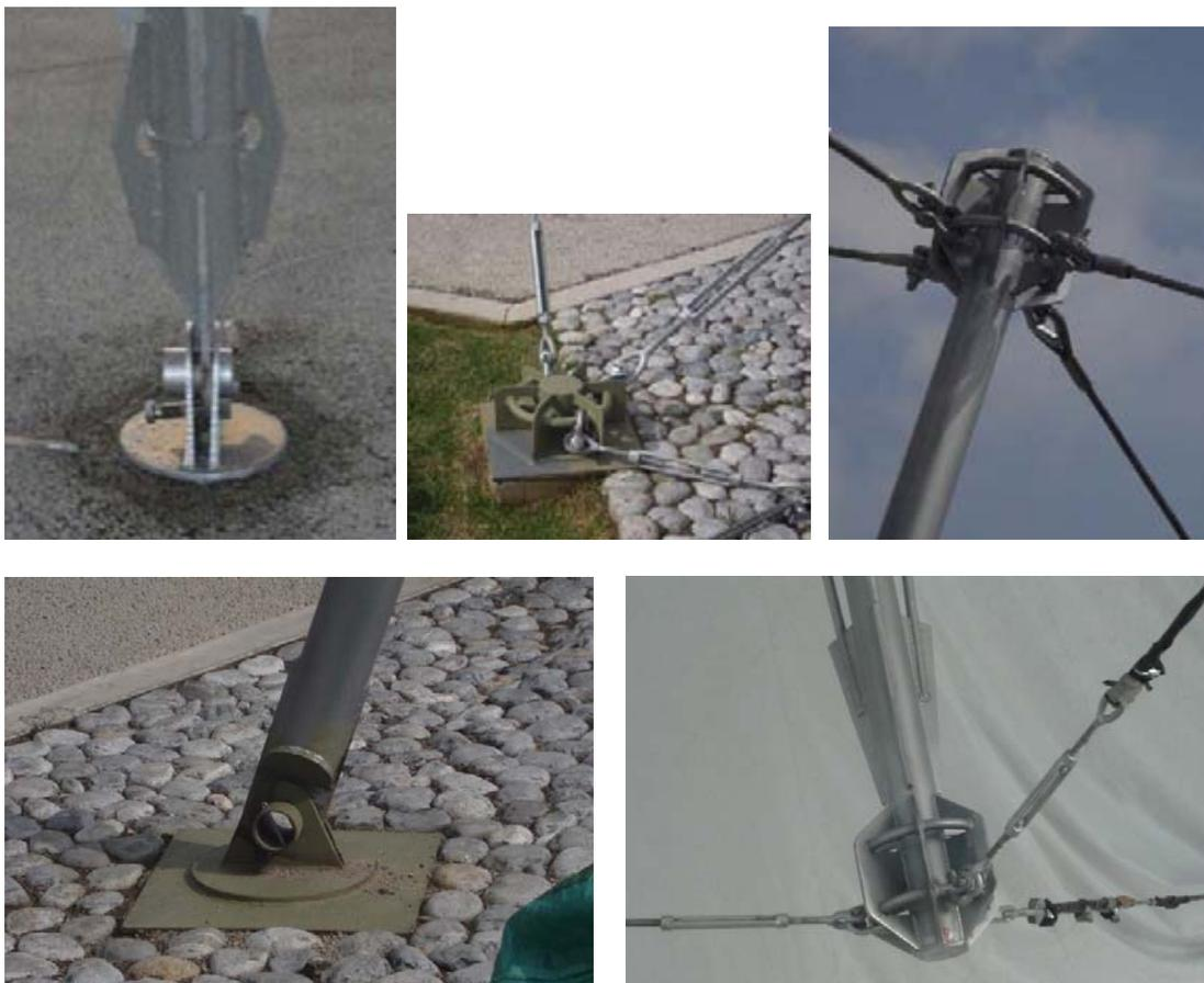
**Figs. Nº 107, 108, 109, 110 y 111 Detalles de Anclajes de mástiles y cables.**
