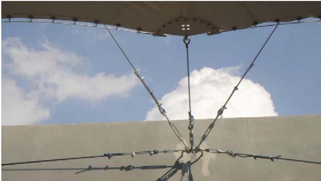
**Fig. 79 Anclaje de extremo de cables con templadores a horquetas.**
