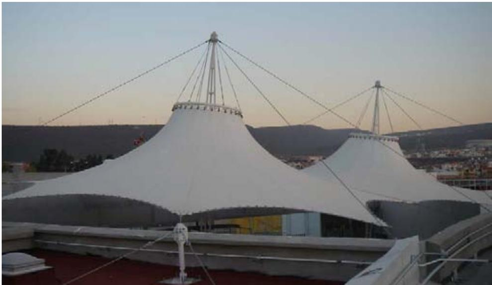
**Fig. 71** Cubierta de Lona Fortoflex de 800 grs x m2 con black-out.
