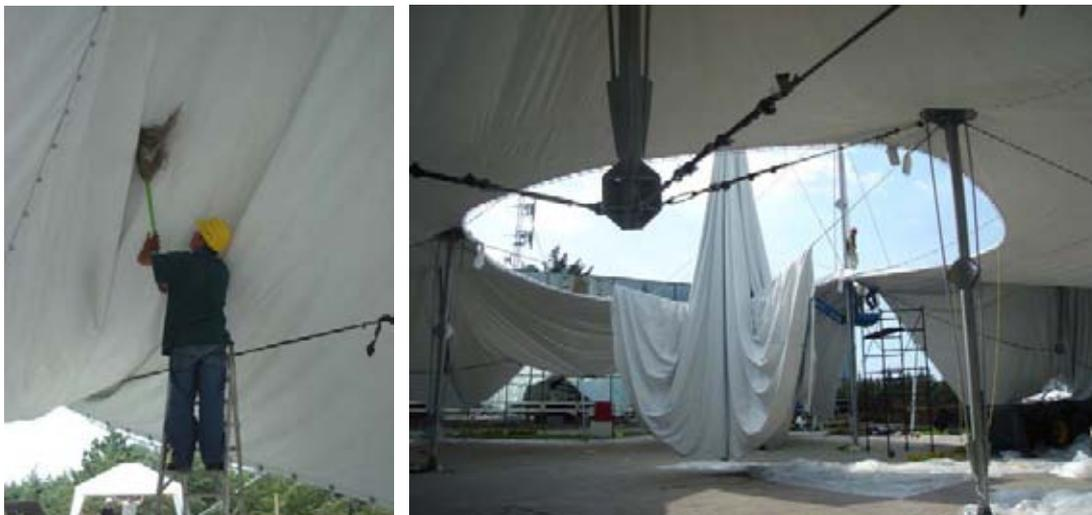
**Figs. Nº 115 y 116 Limpieza y montaje del manto. Cables forrados para evitar suciedad.**
