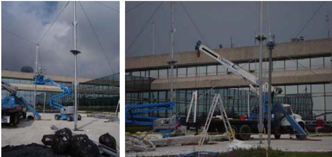
**Figs. Nº 105 y 106 Posicionamiento de los mástiles principales y de contrarresto.**
