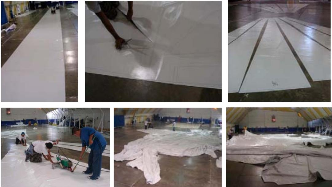
**Figs. Nº 89, 90, 91, 92, 93 y 94 Procedimiento de Corte y termo soldado del manto.**
