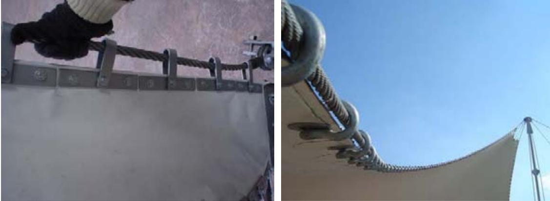
Fig. N° 160 y 161 Sistema de anclaje de Cable de relinga al manto. Inicial y final
