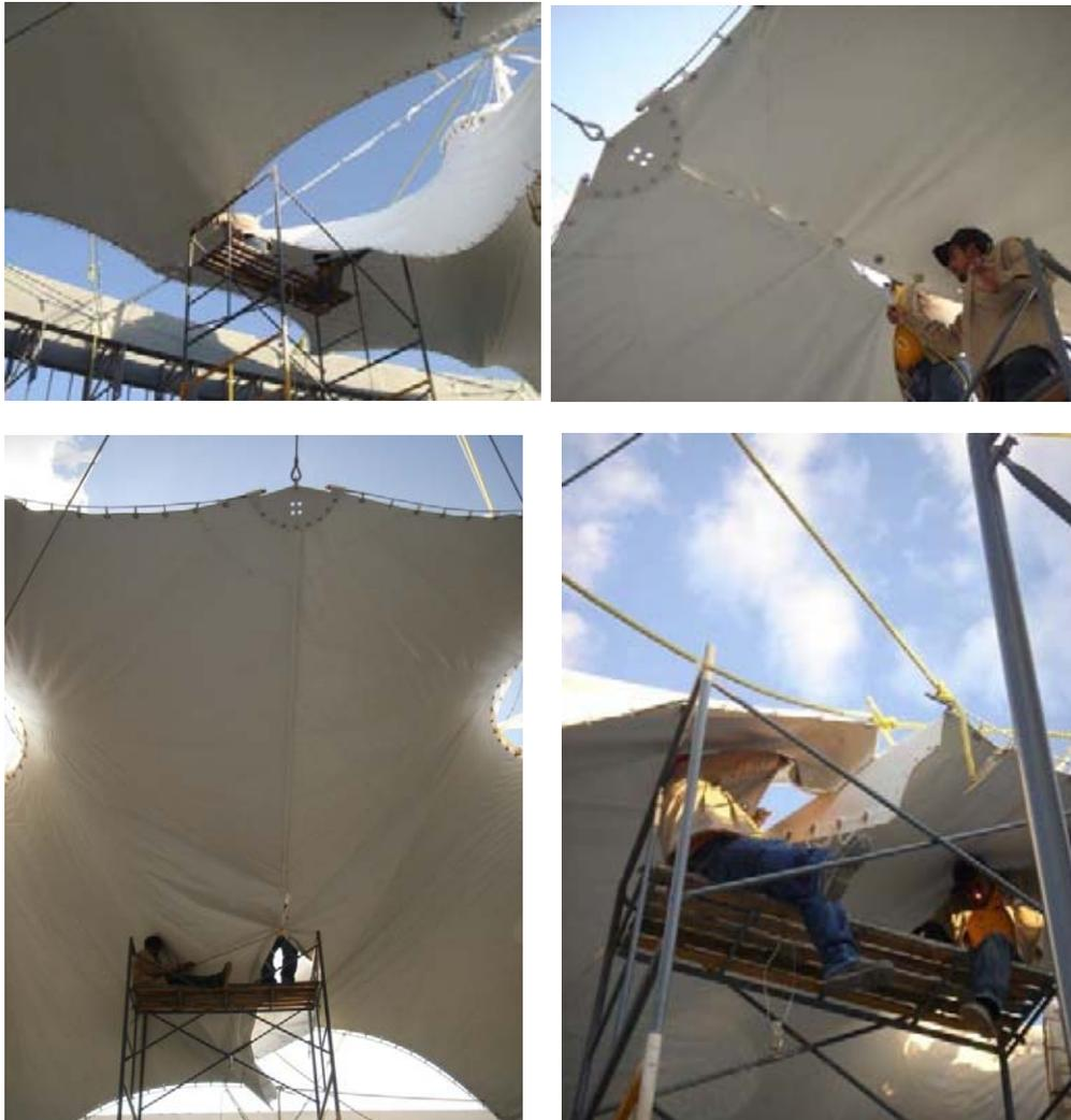
**Fig. N° 73, 74, 75 y 76** Proceso de costura con piola, entre las dos logarítmicas.
