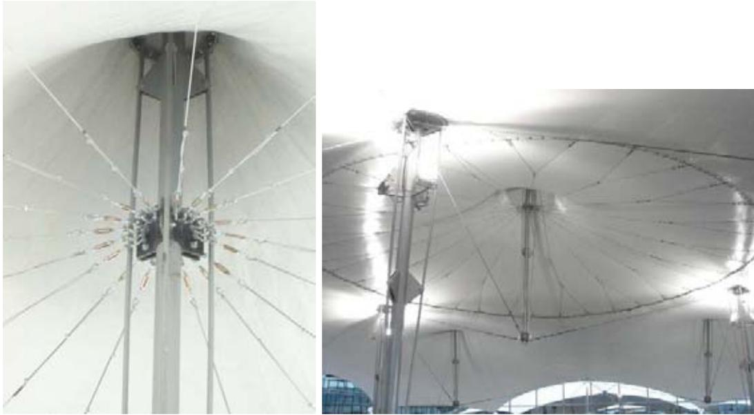
**Figs. N° 122 y 123 Arreglo de cables en módulo central.**
