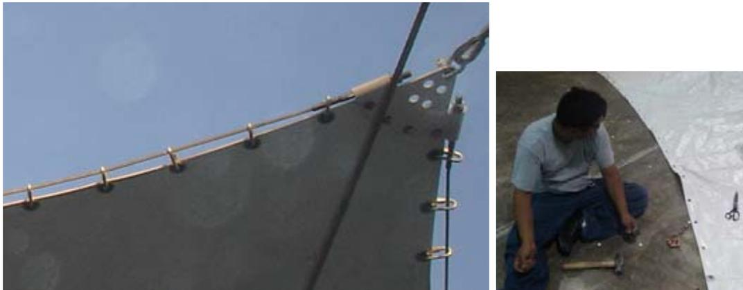
Fig. N° 77 Detalle de conexión de Cable de relinga a manto y ojillos.
