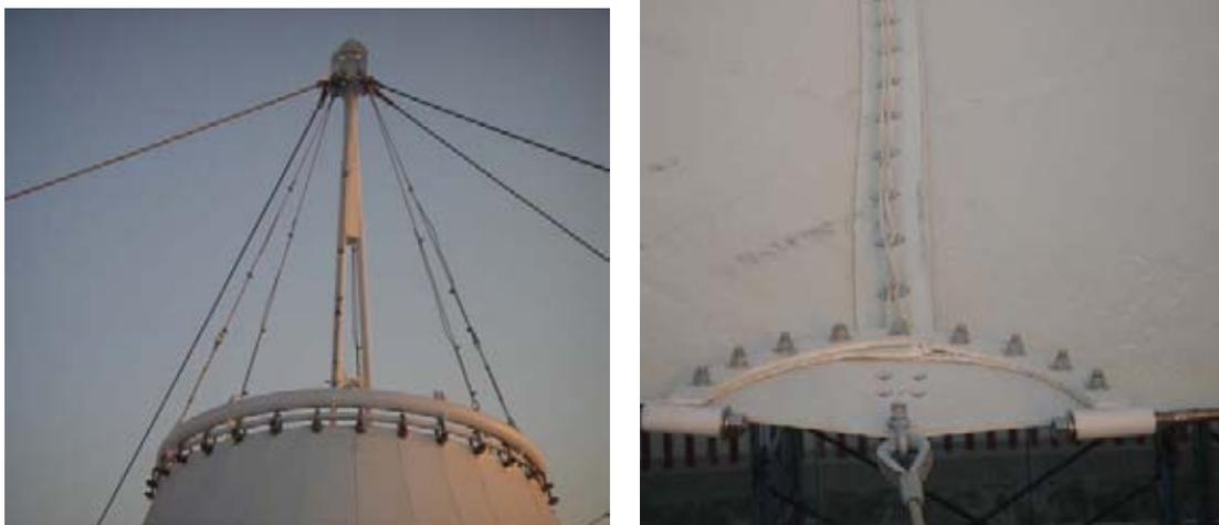
Figs. 83 y 84 Detalle de anclaje de lona a anillo y detalle de costura entre los dos mantos.
