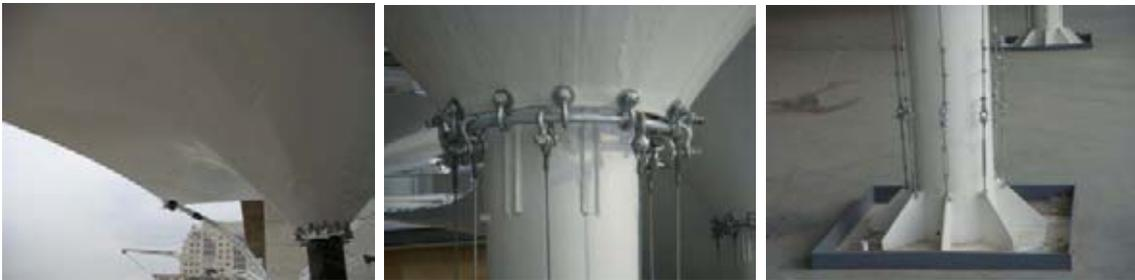
**Figs. Nº 149, 150 y 151 Tensado final del manto.**
