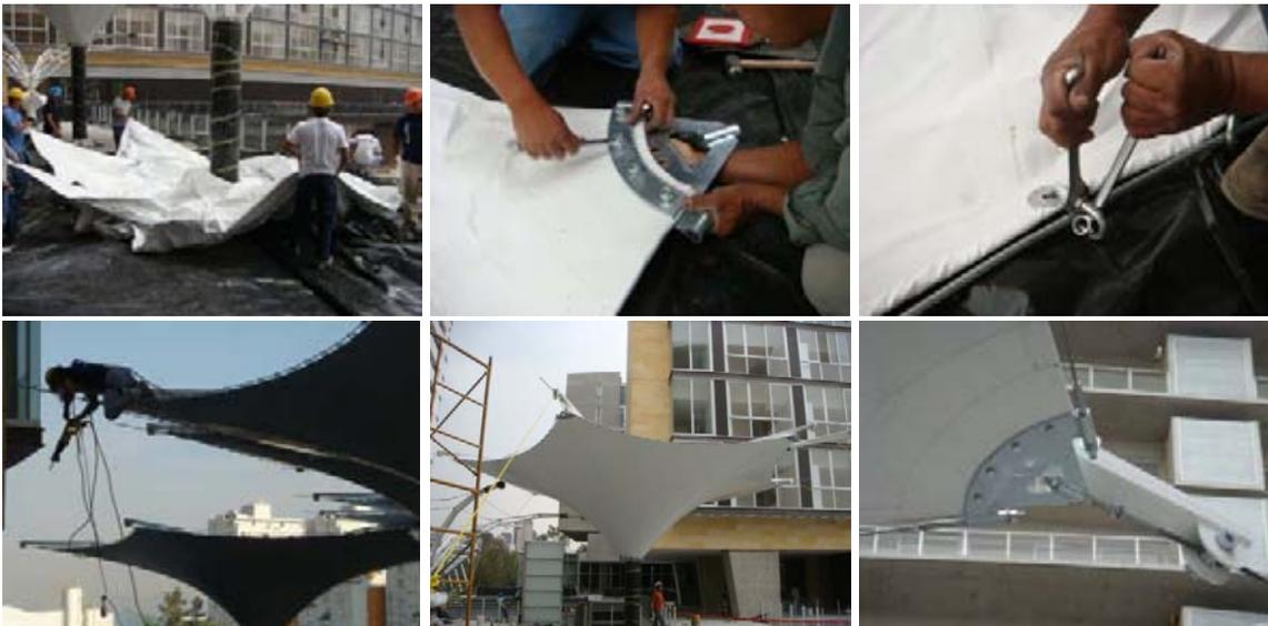
Figs. N° 143 a 148 Desdoblado y armado de accesorios de conexión al manto.
