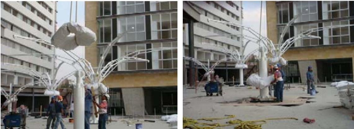
Figs. N° 141 y 142 Posicionamiento de mantos de lona antes de montar brazos.
