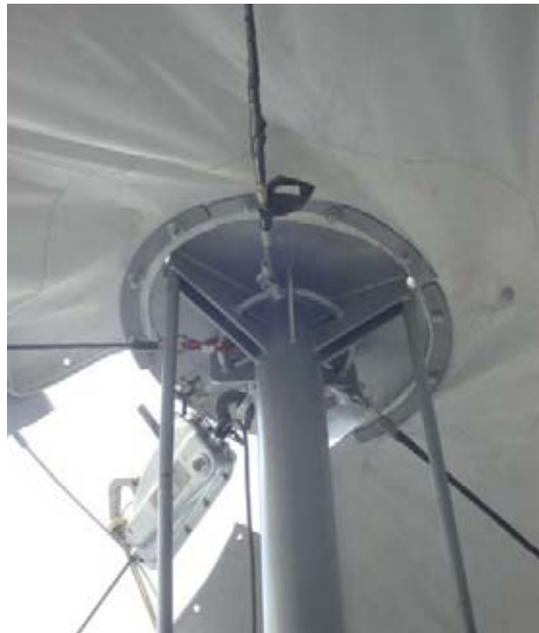
Figs. Nº 99, 100, 101 y 102 . Las placas de conexión con el manto, deben coincidir.
