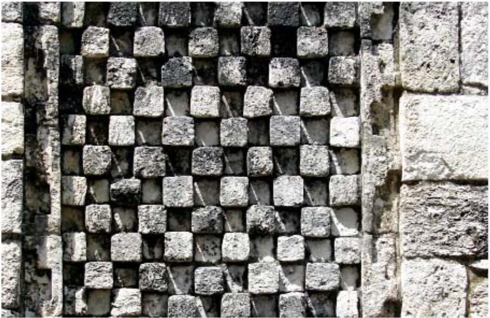
36. Detalle del techo del Camino Real, México DF
