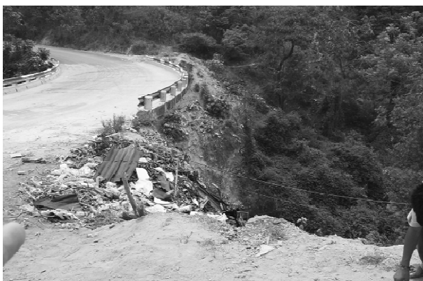
Figura no. IV-10 Tiradero irregular ubicado sobre la carretera Atoyac - Puerto del Gallo
