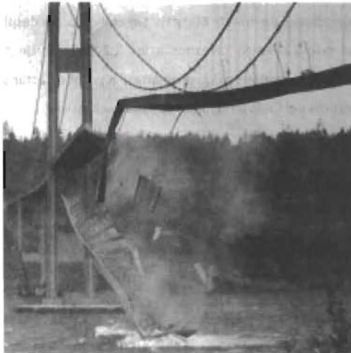
Figura I.3.1.2 El puente de Tacoma al momento de su falla 2
