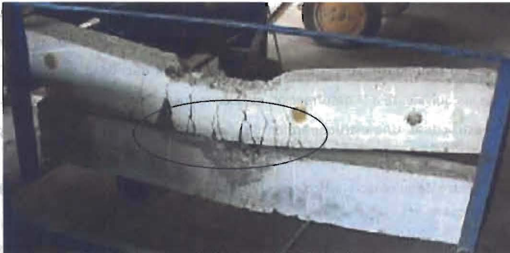
Figura I.3.6.1 Viga subreforzada fallada 5
