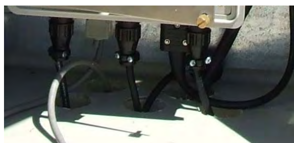
Figura 4.8 Perforaciones para el paso de los cables.
