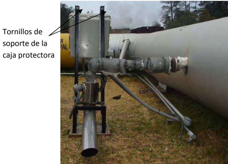
Figura 4.9 Instalación de la caja protectora
