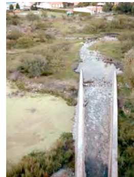
Compuerta principal de la presa Tequisquiapan, Tequisquiapan, Orn
