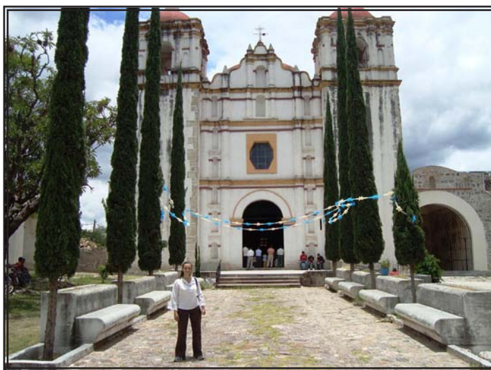
Figura 2: Fachada del templo de San Juan Bautista Teitipac concluida hasta el siglo XVIII con el portal que accede al exconvento al sur del mismo.
