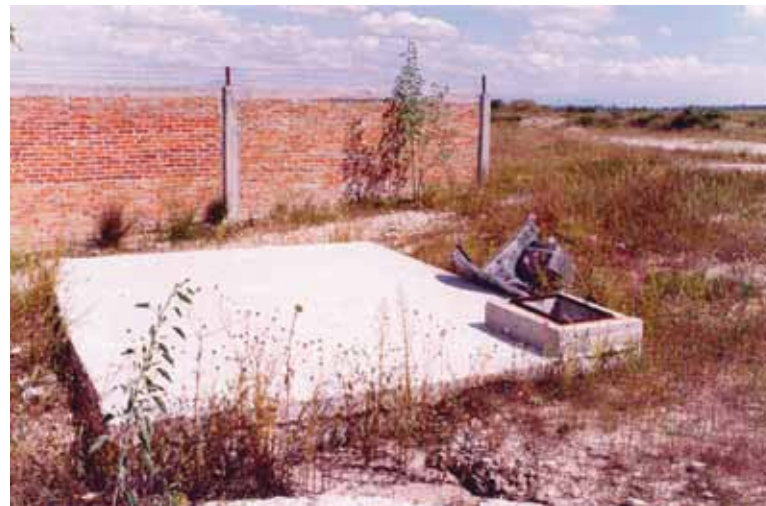
Caseta de vigilancia en la entrada al terreno para el proyecto
