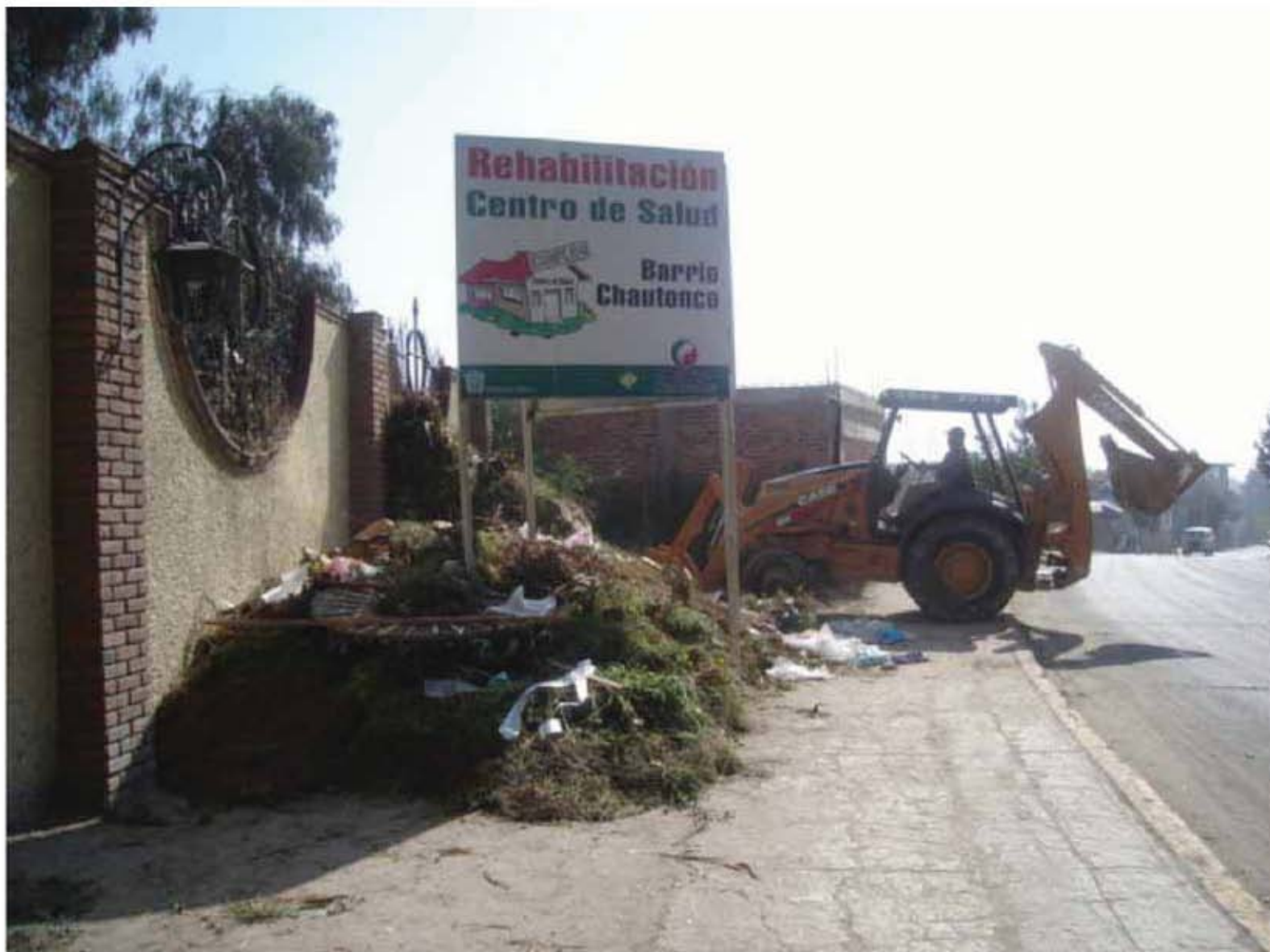
Acumulación de basura orgánica en la fachada principal del cementerio actual del Municipio de Coyotepec, Estado de México
