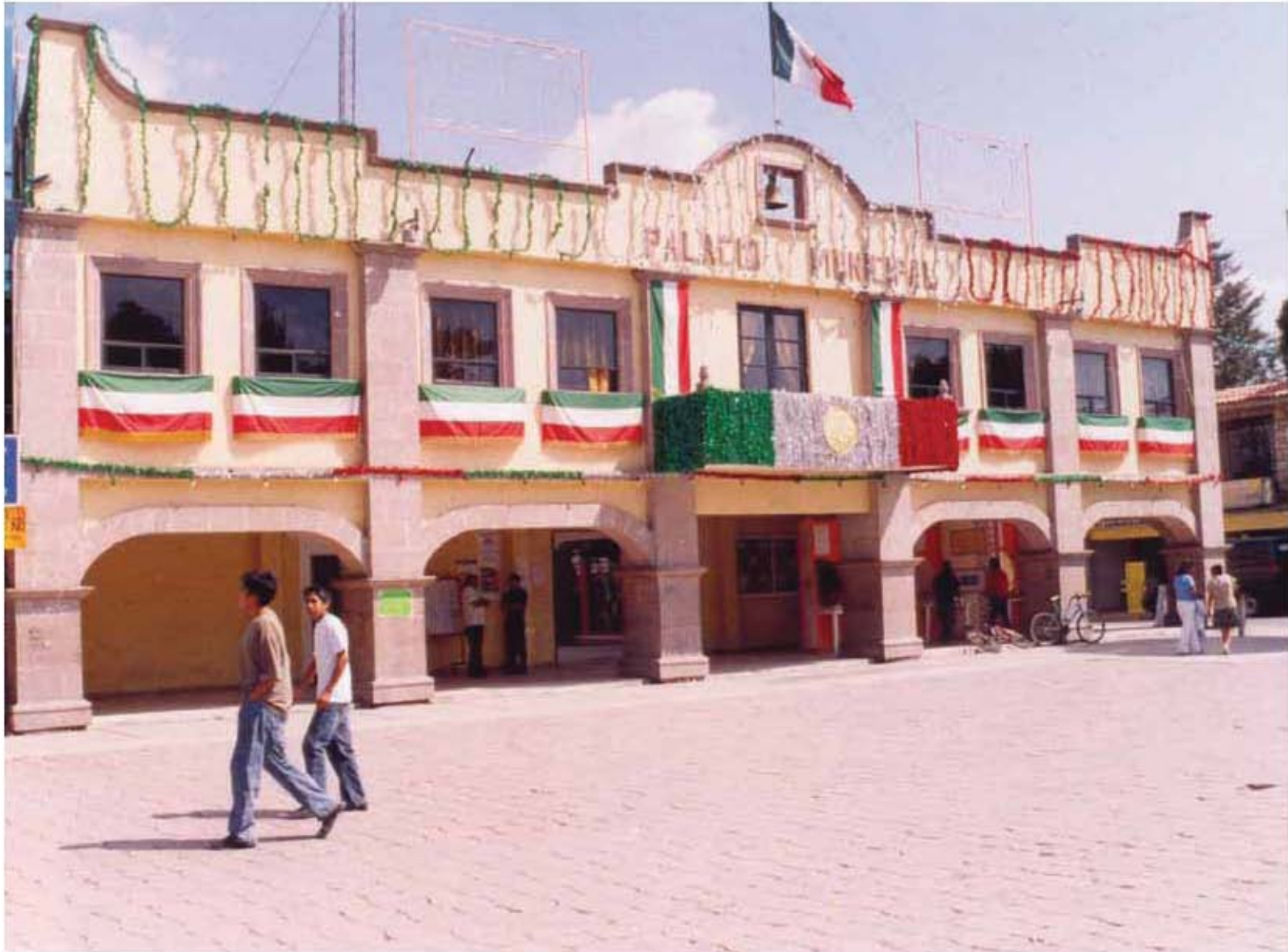
Palacio Municipal de Coyotepec, Estado de México
