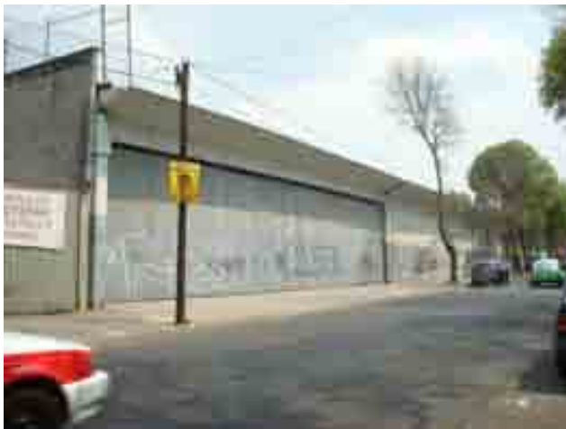
Fachada trasera del terreno
