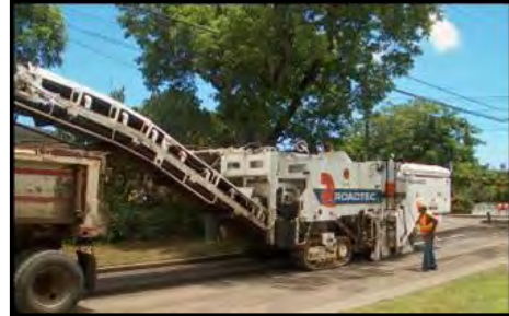
FIG. 3.7 CORTE DE ASFALTO. FRESADORA CON BANDA TRASPORTADORA
