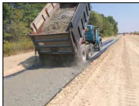
FIG. 3.28 DESCARGA DEL MATERIAL GRANULAR SOBRE LA GEOMALLA
