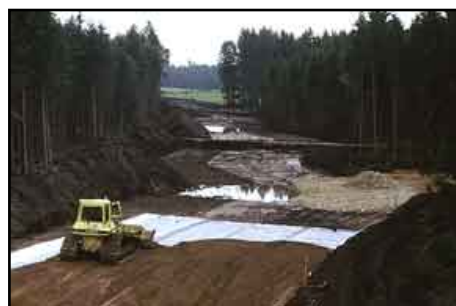
FIG. 3.26 PREPARACIÓN DEL SITIO. ACCIONES DE DESMONTE Y DESPALME
