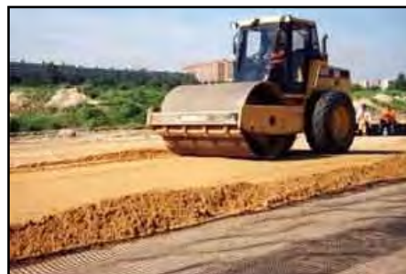
FIG. 3.30 COMPACTADO DEL MATERIAL DE RELLENO SOBRE LA GEOMALLA
