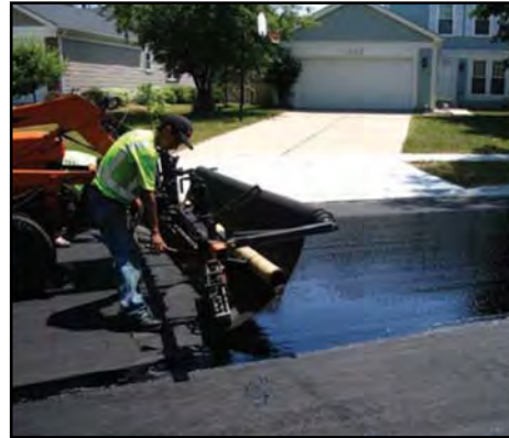
FIG. 3.10 COLOCADO DE GEOTEXTIL CON EQUIPO ESPECIALIZADO
