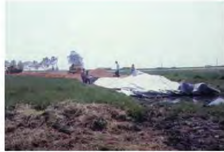
Construcción de una vía no pavimentada reforzada sobre arcilla orgánica blanda
