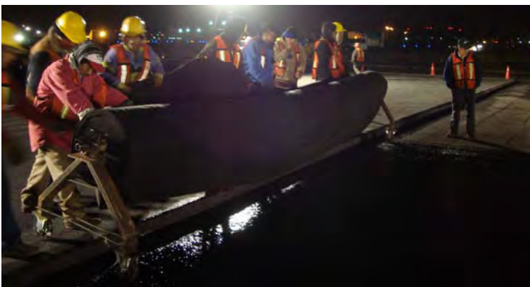
FIG. RA.4 COLOCADO DE GEOTEXTIL CON AYUDA DE UNA CARRITO, DISEÑADO POR EL CONTRATISTA, EN LA PISTA 05R-23L DEL AEROPUERTO INTERNACIONAL DE LA CIUDAD DE MÉXICO, NOVIEMBRE 2008
