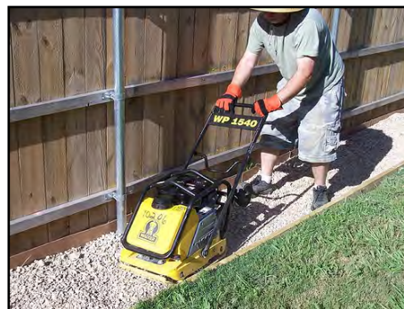
FIG. 3.2 COMPACTADO DE AGREGADO CON COMPACTADOR VIBRATORIO
