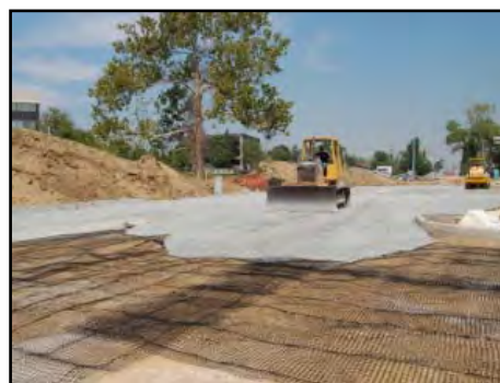
FIG. 3.29 ESPARCIMIENTO DEL MATERIAL GRANULAR SOBRE LA GEOMALLA
