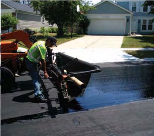
FIG. RA.1 COLOCADO DE GEOTEXTIL CON EQUIPO ESPECIALIZADO EN UNA CALLE
