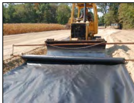
FIG. 3.27 COLOCACIÓN DEL ROLLO DE GEOSINTÉTICO
