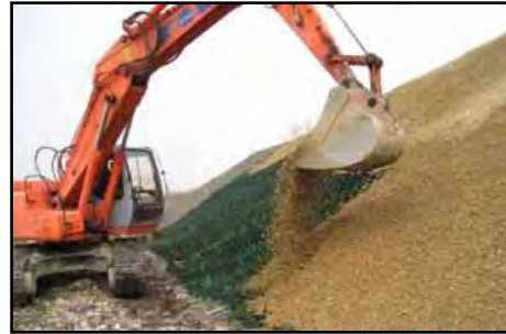
FIG. 3.40 RELLENO CON TIERRA VEGETAL SOBRE LAS GEOCELAS
