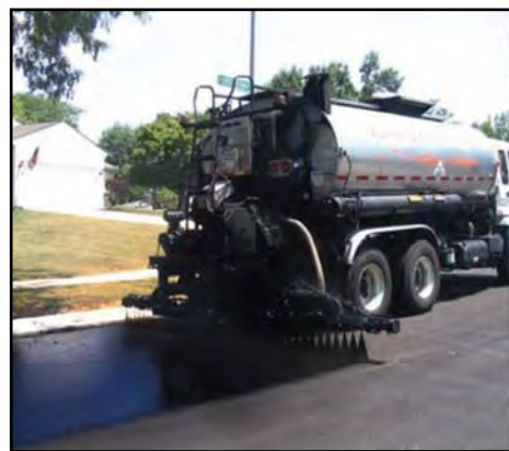
FIG. 3.9 PETROLIZADORAS HACIANDO RIEGO DE EMULSIÓN TIPO AC
