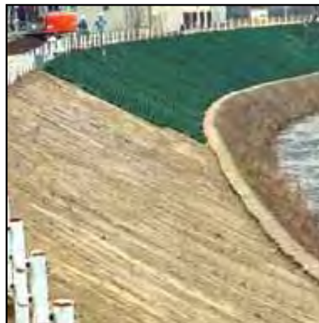
FIG. 3.37 TALUD LIMPIO Y LISO PARA RECIBIR LOS PANELES DE GEOCELDA
