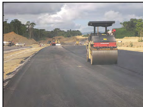
FIG. 3.12 COMPACTACIÓN DE LA CARPETA ASFALTICA
