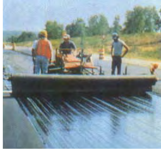
FIG. RA.2 COLOCADO DE GEOTEXTIL CON EQUIPO ESPECIALIZADO EN UNA CARRETERA
