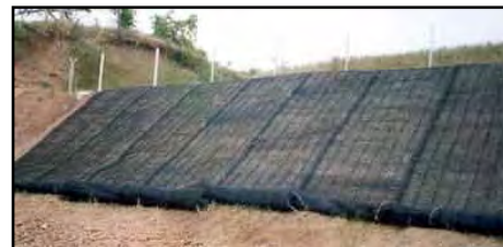
FIG. 3.36 GEOMANTAS COLOCADAS LISTAS PARA LA HIDROSIEMBRA
