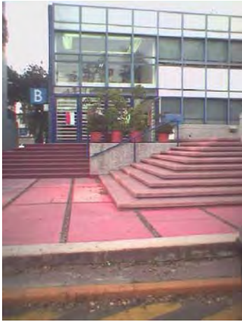
FOTO No. 22 Parte de la fachada sur
