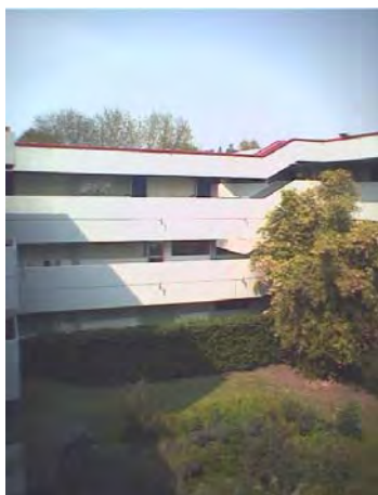
FOTO N° 5. Fachada interna sur.
