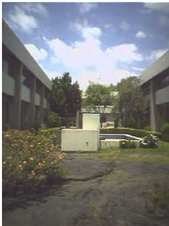
FOTO No. 31 Fachada interna lateral sur.
