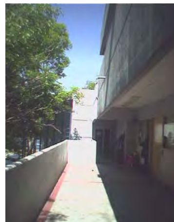
FOTO N° 6. Fachada interna sur, otro ángulo de perspectiva
