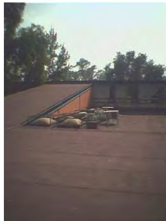
Foto No. 16 Parte del techo del edificio.
