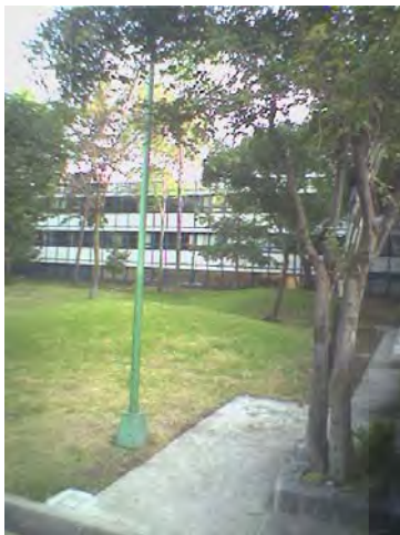
FOTO No. 20 Fachada norte del edificio B
