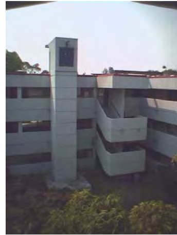
FOTO N° 4. Fachada interna oriente
