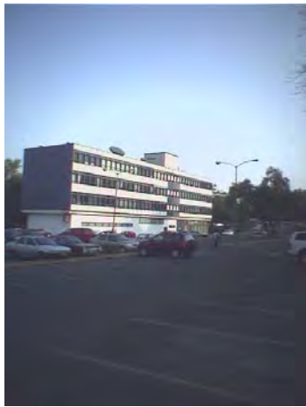
FOTO No. 17 Fachada poniente del edificio A.
