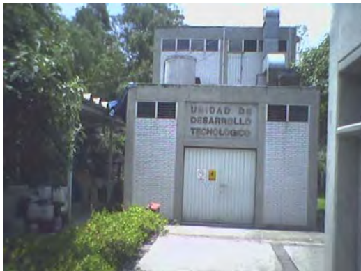
FOTO No. 40 Fachada sur de la UDT.
