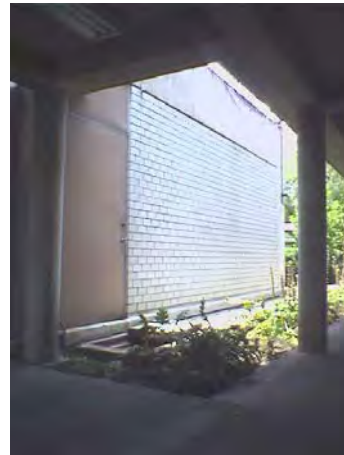
FOTO No. 39 Vista de la fachada sur del edificio
