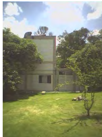
FOTO No. 41 Fachada lateral este de la UDT.
