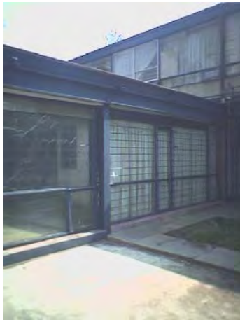
Foto No. 14 Fachada norte e interna poniente (patio) del edificio
