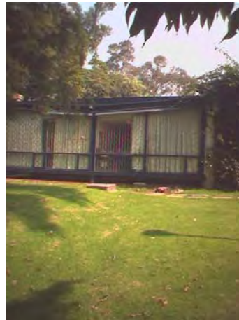
Foto No. 15 Parte de la fachada principal oriente del edificio.
