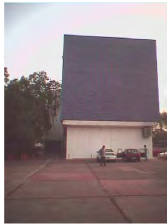
FOTO No. 18 Fachada norte del edificio A.
