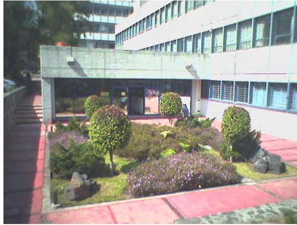
FOTO No. 23 Fachada posterior del edificio B
