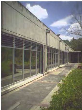
FOTO No. 38 Vista lateral de la fachada oeste del edificio
