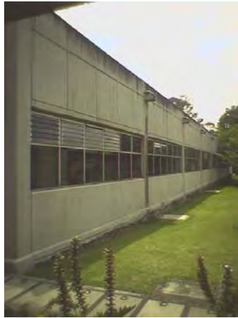
FOTO No. 36 Fachada este del edificio C de laboratorios
