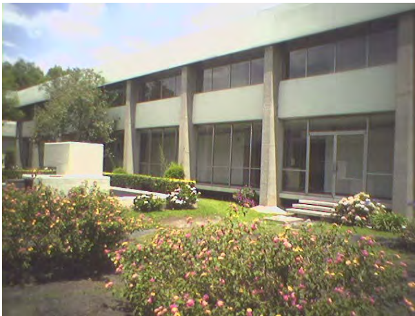
FOTO No. 30 Fachada interna lateral norte.
