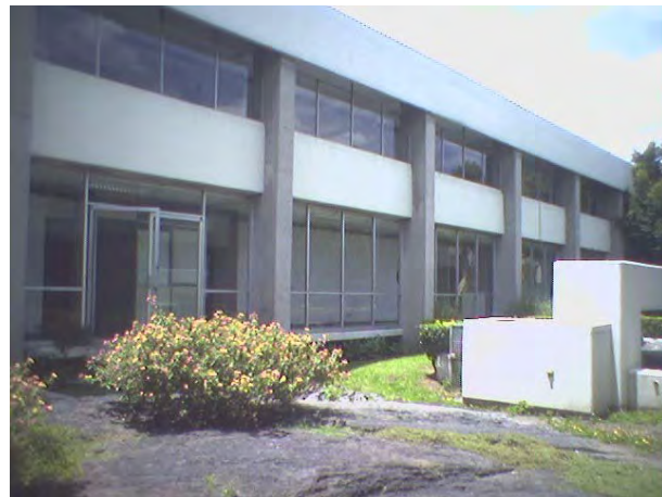
FOTO No. 32 Fachada interna oeste.
