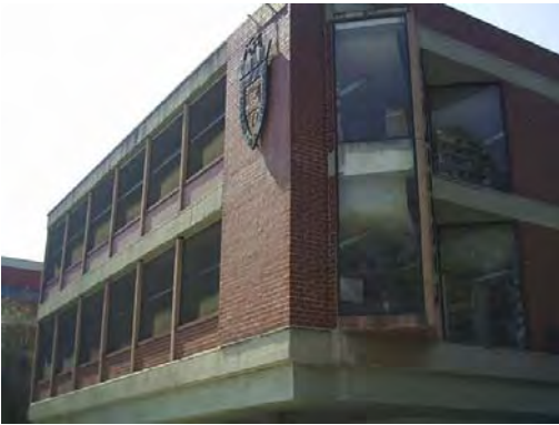
Foto del edificio de la Biblioteca
