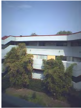
FOTO N° 3. Fachada interna poniente
