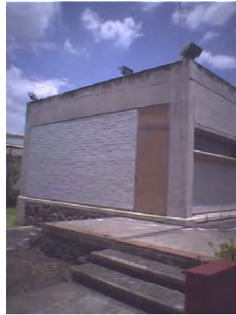
FOTO No. 37 Fachada norte del edificio C de laboratorios.
