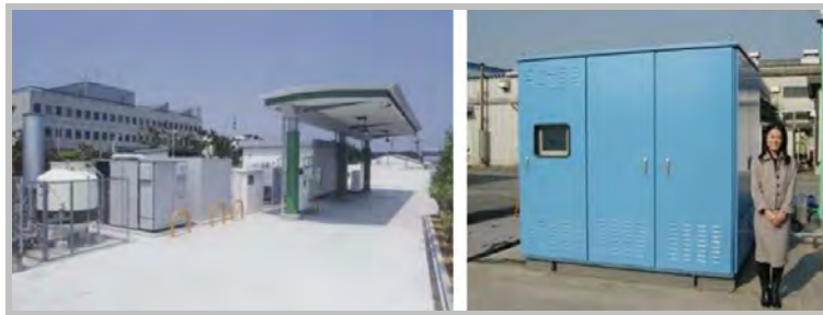
Figura 4.5- Estación de abastecimiento de hidrógeno comprimido de la Corporación japonesa Osaka Gas (izquierda) y módulo compacto de producción de hidrógeno por reformación HYSERVE (derecha) (Tanaka y col., 2007)
