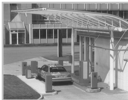
Figura 4.10- Estación de abastecimiento de hidrógeno líquido en el aeropuerto de Munich (Pehr y col., 2001)
