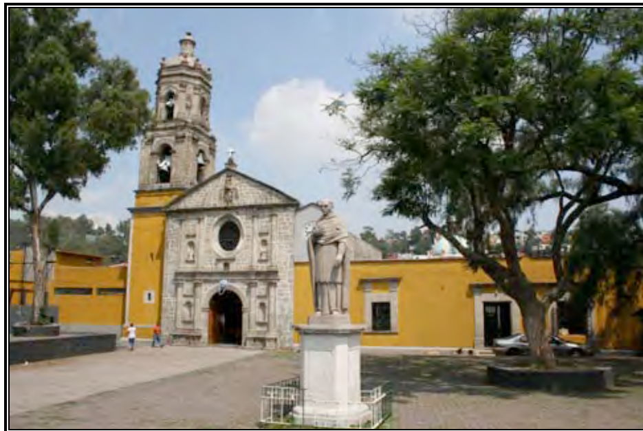
Ilustración 1. Fotografía de la vista actual de la Iglesia de Santa Fe, fundada por Vasco de Quiroga.
