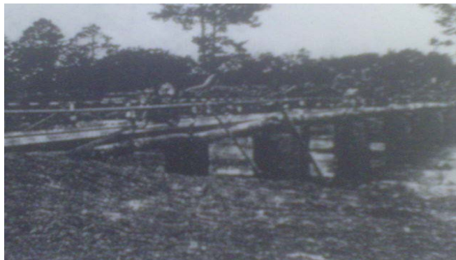
Figura 2.27 Puente de emergencia que se hizo de vigas "I" de acero apoyados por elementos de tubería de concreto
