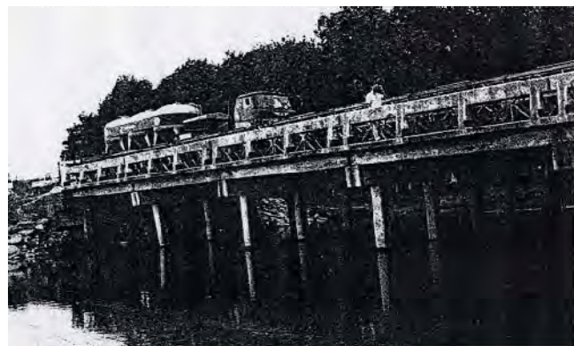
Figura 2.32 Vista de los dañados del puente de la figura 2.31 que fue reforzado
