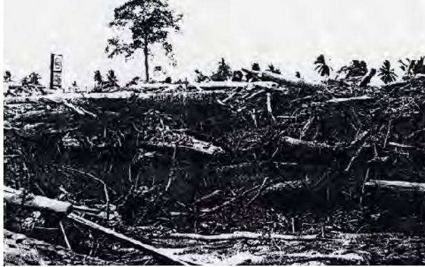
Figura 2.34 Árboles y desechos formaron una barrera aguas arriba del puente
