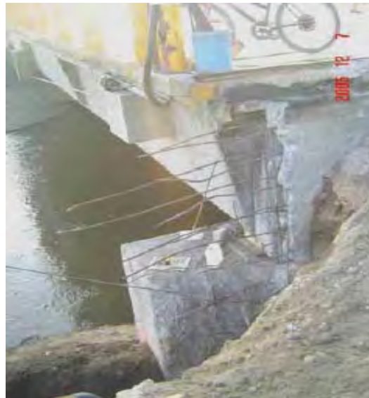
Figura 2.10 Rehabilitación de los estribos del Puente Fronterizo
