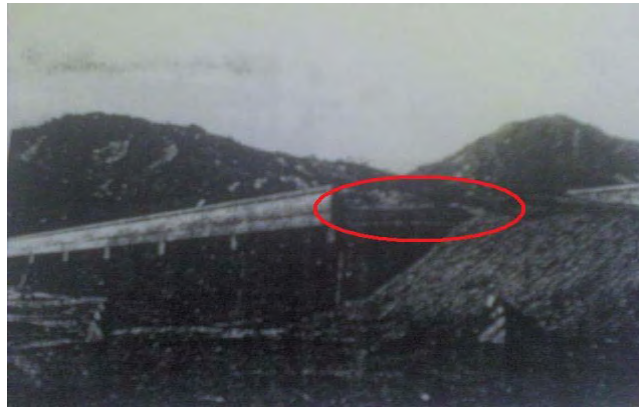
Figura 2.38 Puente en Ban Kathun – Phibun, el terraplén de acceso falló; provocando daño severo en el estribo de apoyo de la superestructura
