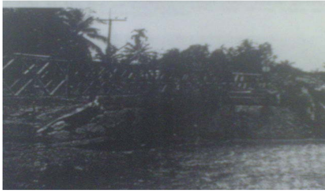
Figura 2.28 Puente Carretero en el Distrito de Phrom Khiri
