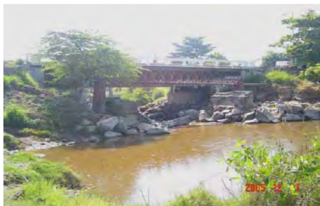
Figura 2.3 Puente San Benito
