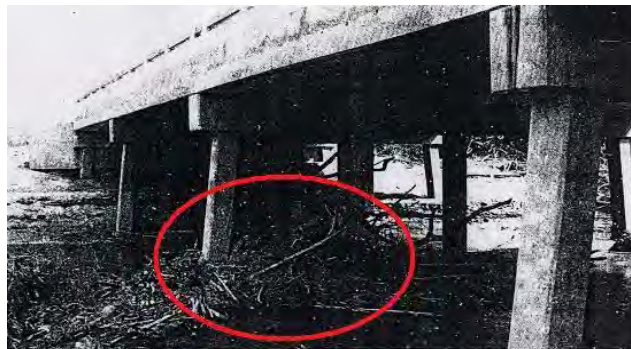
Figura 2.49 Desechos flotantes en el centro del estribo del puente, cerca de Ban Nasan, en Diciembre de 1988
