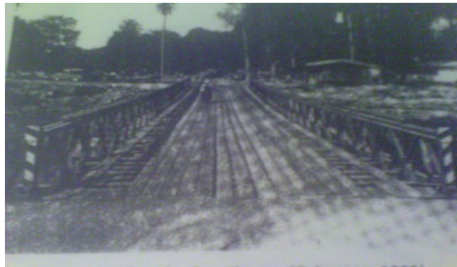
Figura 2.46 Puente de emergencia en Ban Nasan en Febrero de 1989
