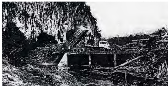
Figura 2.33 Reconstrucción del terraplén de acceso
