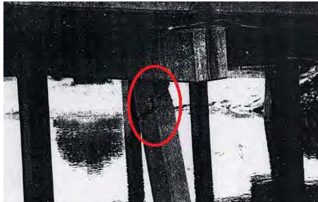
Figura 2.31 Detalles de los daños estructurales en el estribo del puente a lo largo de la carretera 41, cerca de Ban Nasan, en Diciembre de 1988
