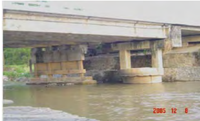
Figura 2.21 Superestructura y subestructura del puente Tepuzapa
