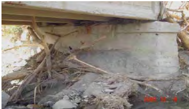
Figura 2.17 Subestructura del puente de la colonia obrera
