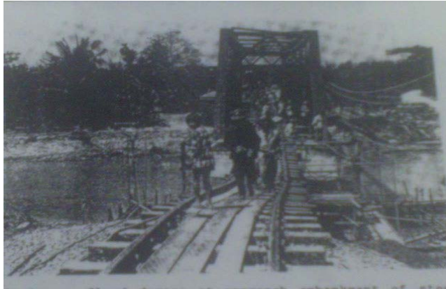
Figura 2.44 Daños en el terraplén de acceso de puente ferroviario en el Distrito de Ban Nasan, una de las principales vías férreas de Tailandia a Malasia
