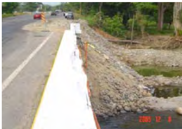
Figura 2.12 Zona del puente que se rellenó con material térreo
