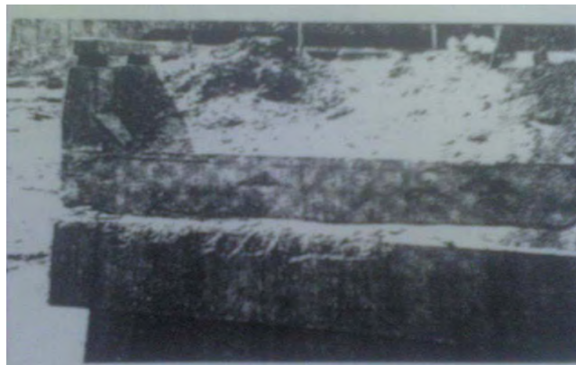
Figura 2.39 Detalle de estribo y apoyo del puente mostrado en la figura 2.38
