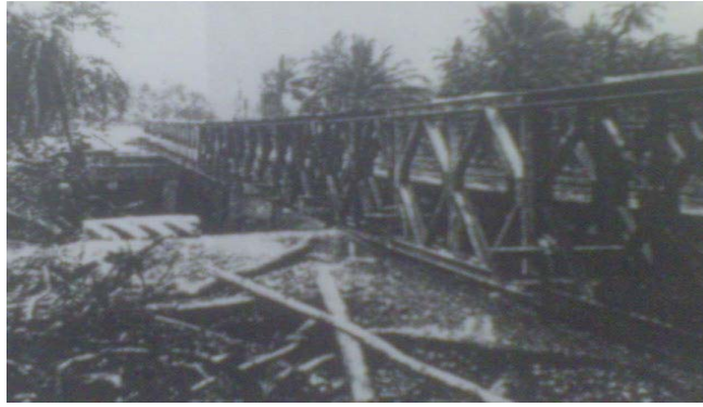
Figura 2.47 Puente de emergencia
