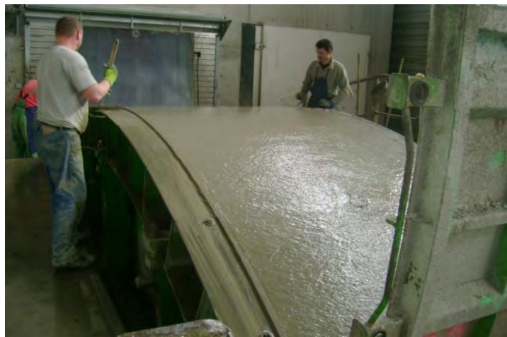
Figura 3.2.2 Fabricación de dovelas
