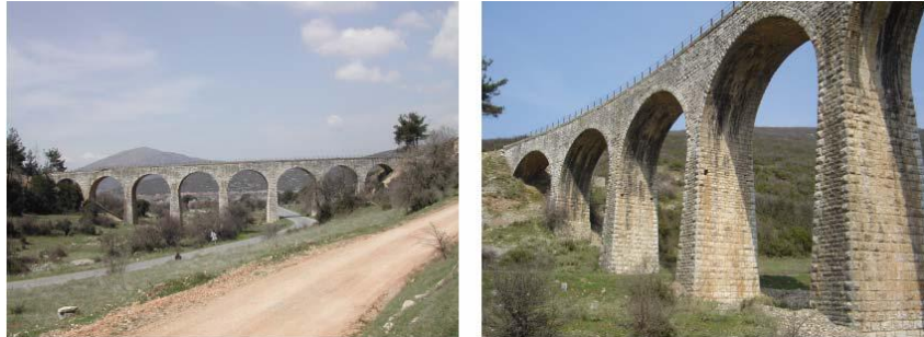
Figura 1.1. Vistas del puente “Manari”
