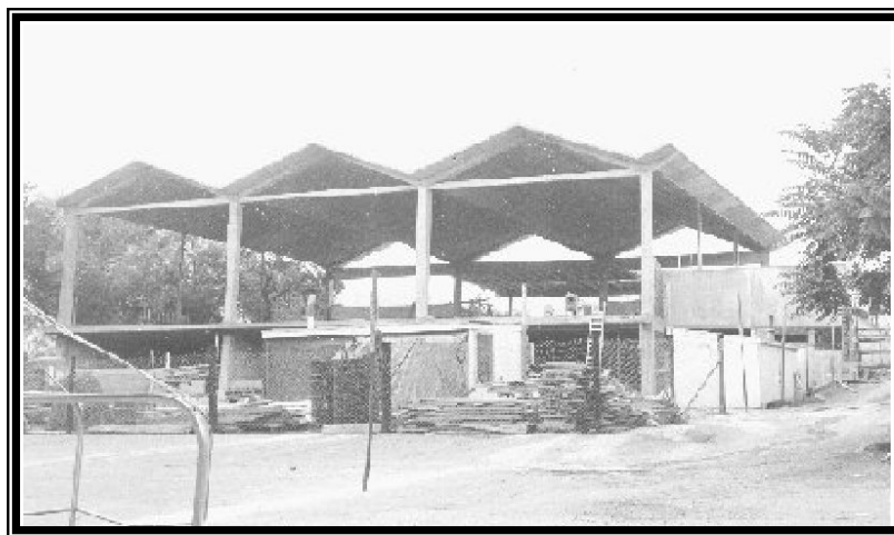
Figura 2.3.1. Sistema de 8 placas plegadas para techar un gimnasio de una escuela secundaria. (Milo Ketchum).
