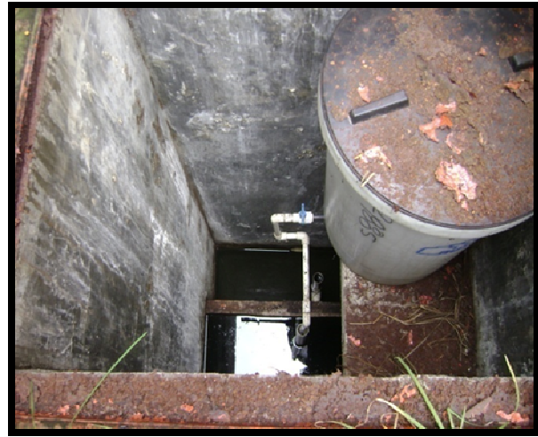
Figura-16 Cámara de cloro de la planta BRAIN de Odontología ala sur
