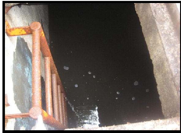
Figura-22 Cisterna central de "Las Islas"
