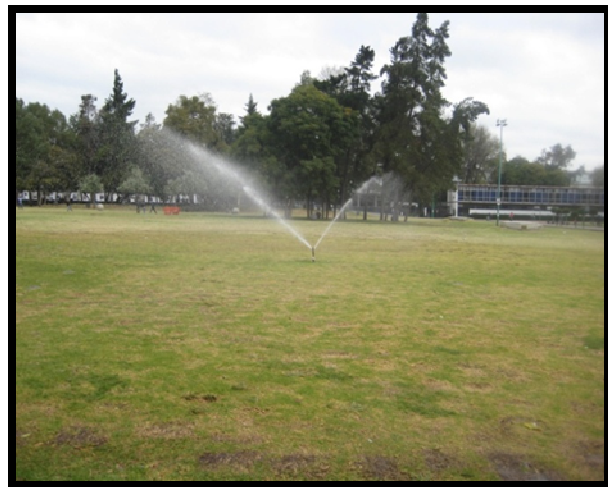
Figura-24 Riego por aspersión con agua tratada en "Las Islas"
