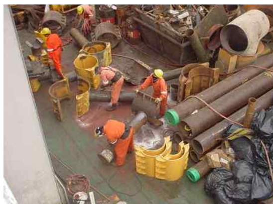
Figura 1.11 – Manejo de tubería de revestimiento durante las operaciones en el campo.
