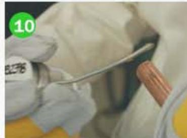
Tome la grasa para soldar, cubra los extremos de los tubos y las partes interiores de las tees y los codos de cobre.
