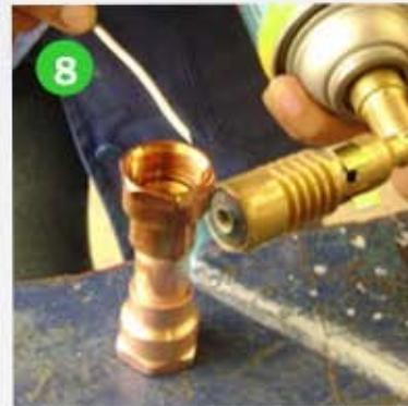
Con los accesorios de cobre que tenemos, hacemos el siguiente arreglo, y lo conectamos a la válvula del flotador.
