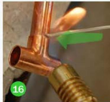
Coloque las piezas en posición vertical y acerque la soldadura de estaño a la union entre el tubo de cobre y la tee.
