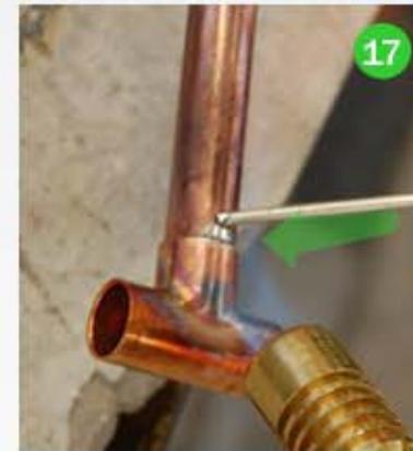
Cuando el tubo esta suficiente caliente la soldadura fluye al momento de tocar el tubo en caso de que no fluya, caliente más el tubo.
