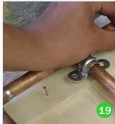
Colocamos las omegas en la parte superior e inferior del serpentín, donde tenemos la unión del tubo de cobre con la tee de cobre.
