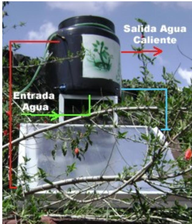
Figura 1 3. Diagrama de instalación
