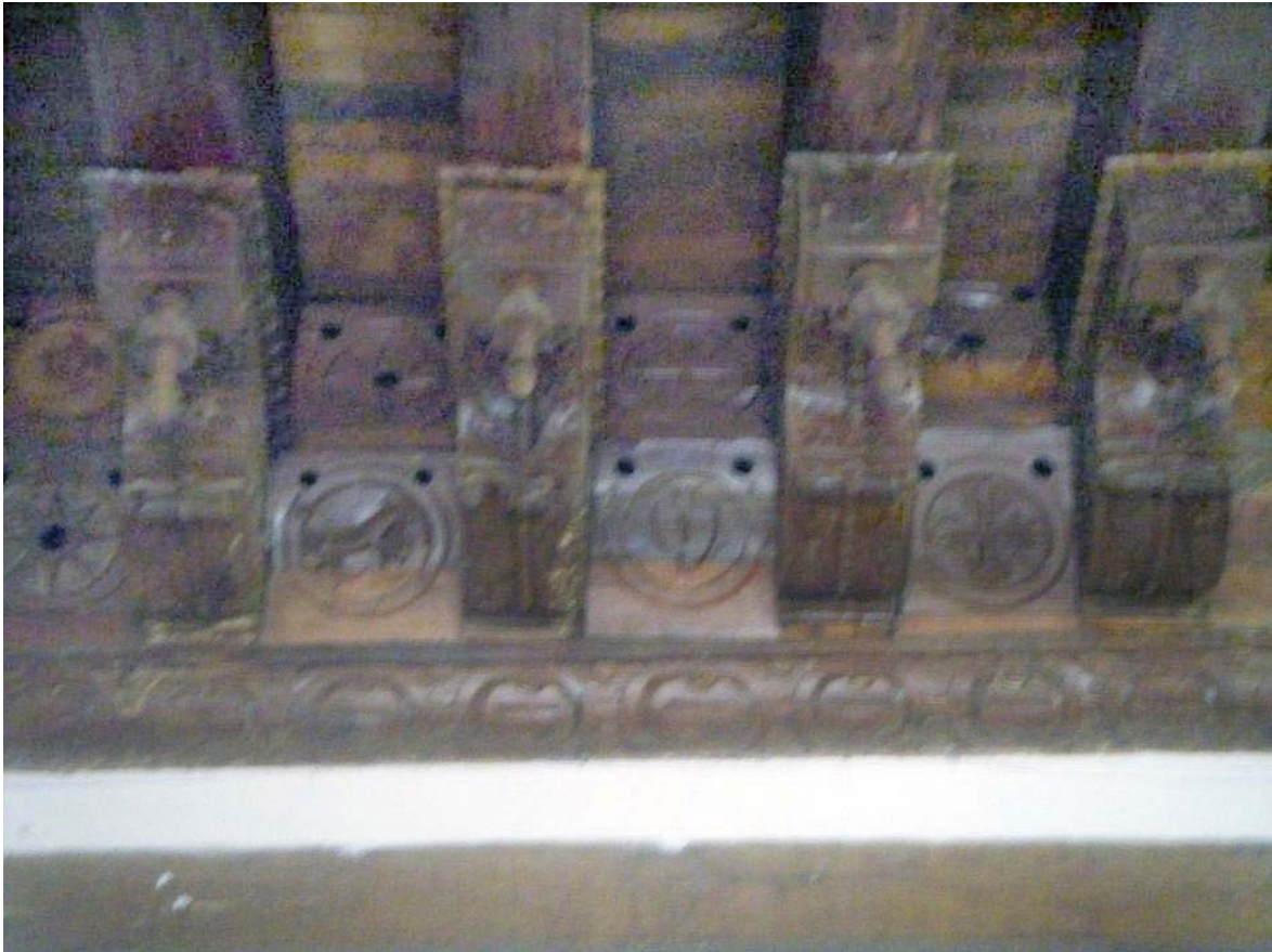
Figura 8. Cubierta de vigería del coro alto de la iglesia de Santa Catalina de Siena. Fotografía de Beatriz Riveros.
