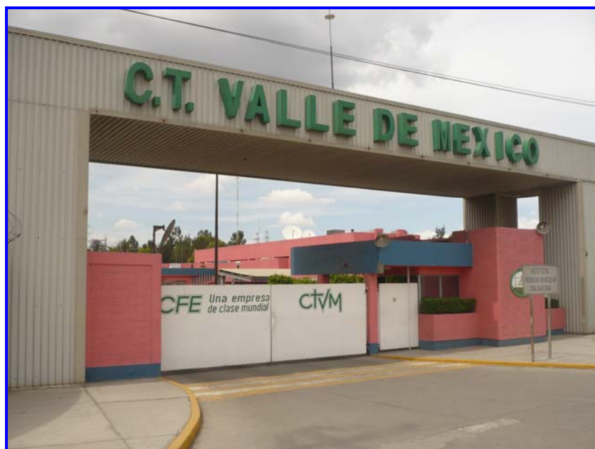
Figura 1.1 Central Termoeléctrica Valle de México.
