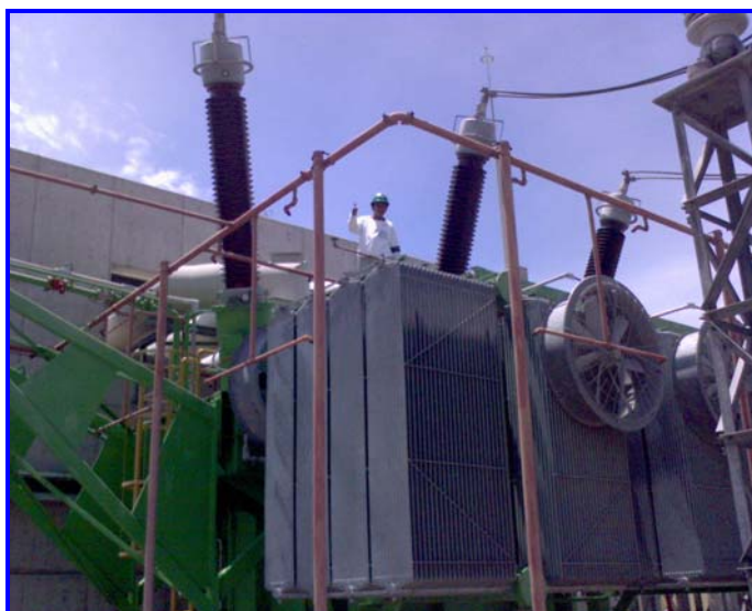
Figura 1.26 Transformador Unidad 5.
