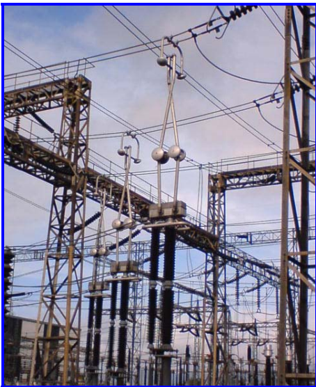
Figura 1.33 Cuchilla tipo pantógrafo.
