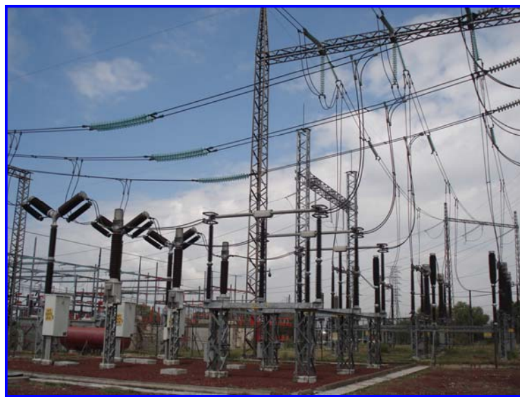
Figura 1.11 Subestación 230 kV.
