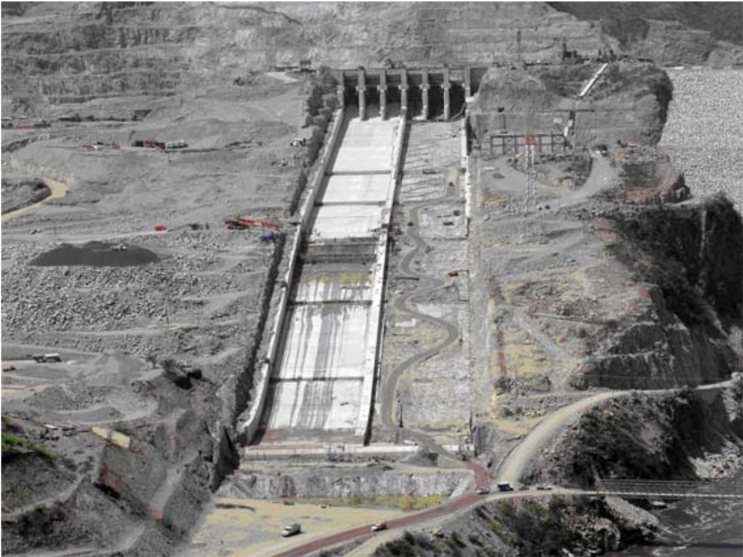
**Fig. 2.35 Vista aguas arriba del vertedor sin agua**
