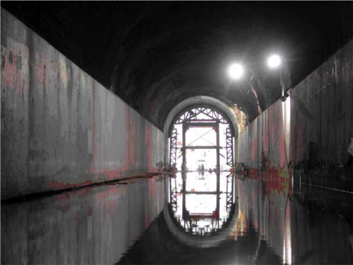
**Fig. 2.21 Compuertas de mantenimiento del túnel de desfogue**
