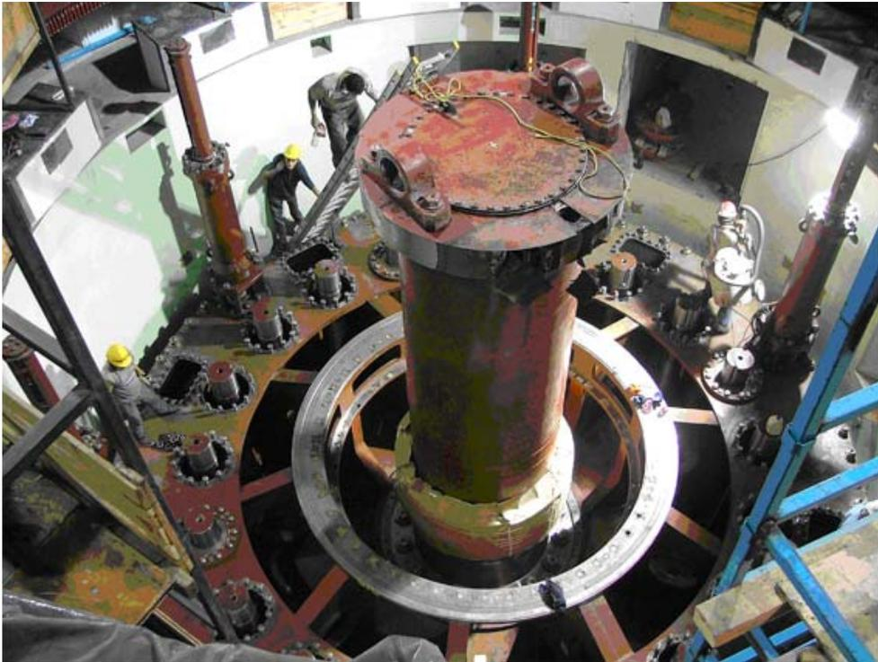
**Fig. 2.17 Armado del laminado del rotor**
