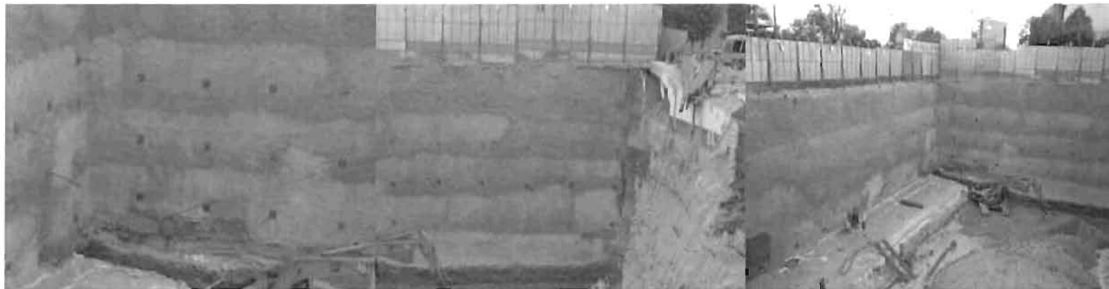
Vista excavación para sótanos estacionamiento.
