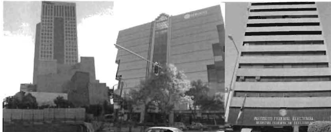
Torre Network 25 niveles
