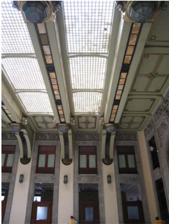
Vista de la techumbre con tragaluces y travesaños de concreto armado de las oficinas de la Tesorería
