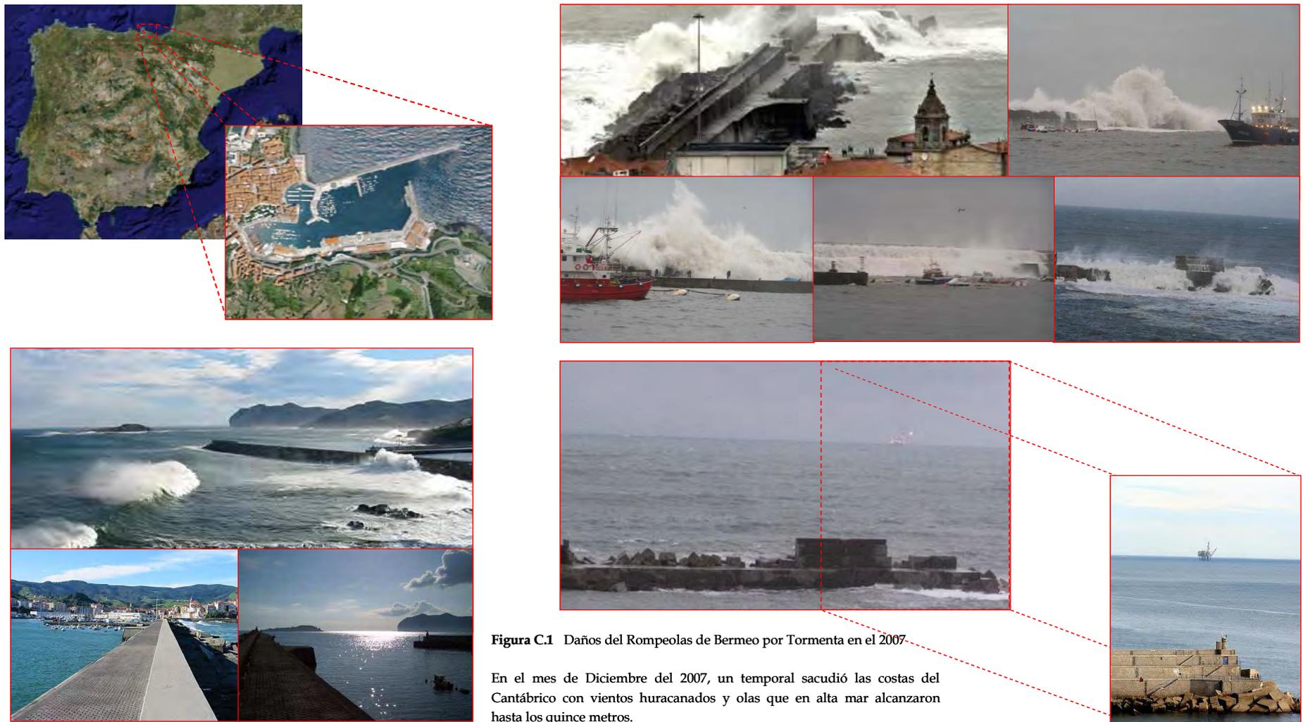
**Figura C.1** Daños del Rompeolas de Bermeo por Tormenta en el 2007
