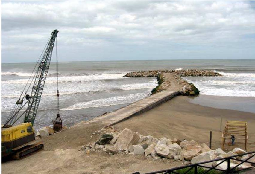
**Figura 3.11** Construcción de un Rompeolas en Talud
