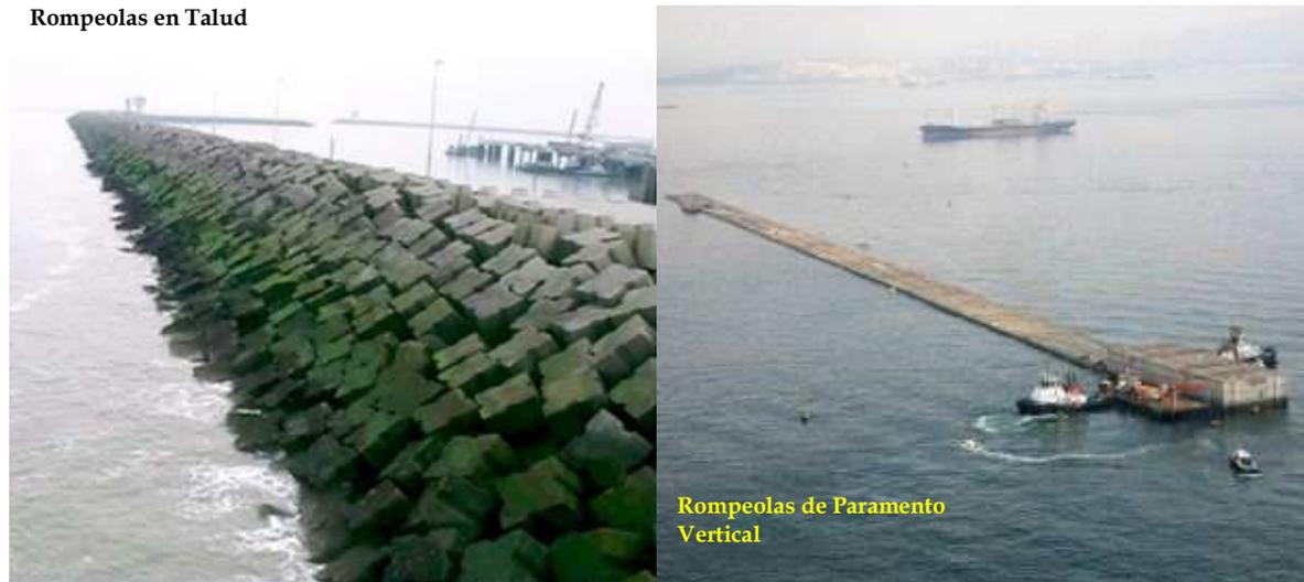
**Figura 3.8** Rompeolas en Talud y Rompeolas de Paramento Vertical
