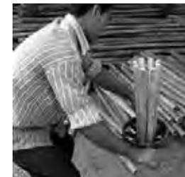
Por el ajuste axial de la fibra en el tallo, esta se deja rajar rápidamente con una cuña, se corta el bambú de acuerdo con la longitud deseada, posterior a esto se coloca de manera horizontal sobre algún apoyo y se coloca el cortador radial, aplicando la fuerza necesaria para el corte. (Ver Figura 77, secuencia de imágenes tomadas de Hidalgo, 2006)
