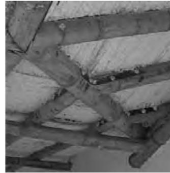
Figura 73, unión de trabes con placas de acero y pernos
