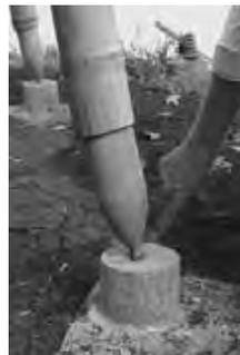
Se hace un murete de concreto del cual sobresale de manera centrada una varilla aprox. 50 cms, en esta varilla se inserta centrada la columna de bambú, posteriormente el bambú se perfora en el entrenodo que esta en contacto con la varilla, y se rellena de concreto. (Ver Figura 67)
