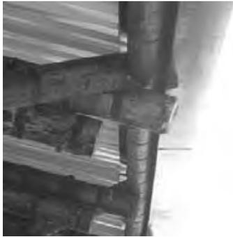
Figura 72, unión de trabes mediante cortes "boca de pescado" y amarres
