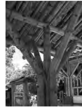
Figura 74, unión de trabes y columnas con cortes "boca de pescado" y pernos
