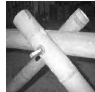
Fig.62- unión con tornillos – Gutiérrez
