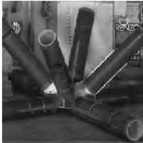
Fig.60 - unión con platina – R.Piano
