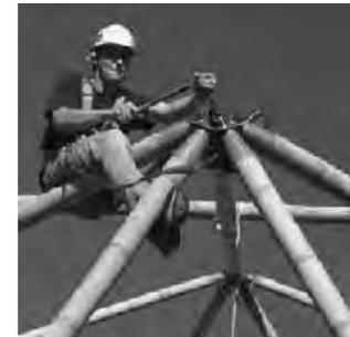
Fig.59 - unión con platina – C.Tönges
