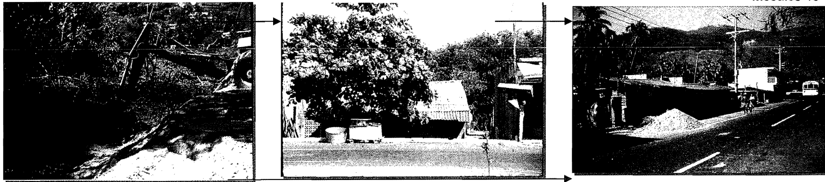
Fuente: Fotos proporcionadas por el Arq. Ramón Fares del Río
