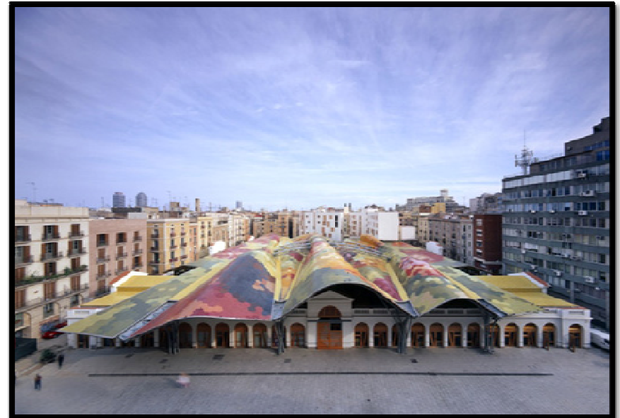
Fachada principal. En esta fotografía se alcanza a observar la cubierta en su totalidad
