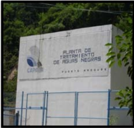
Imagen 14. Planta de tratamiento
