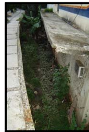
Imagen 12. Vivienda bajo el nivel de calle
