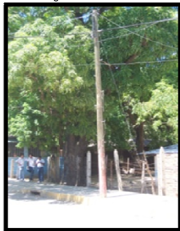
Imagen 19. Poste mal ubicado
