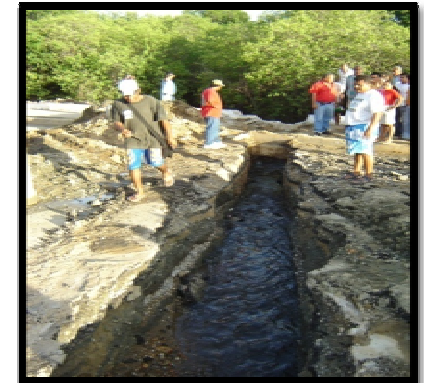
Imagen 17. Pavimentación demolida para desalojar aguas pluviales de viviendas inundadas
