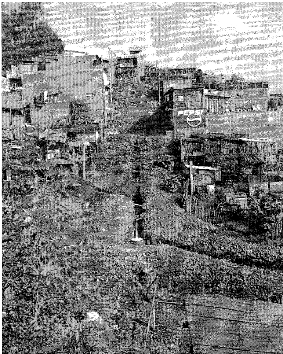
Foto 6. Instalación de la red de drenaje en Rincón Punhuato. 2007
