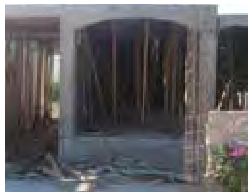
Cambio drástico en la tipología de la vivienda
