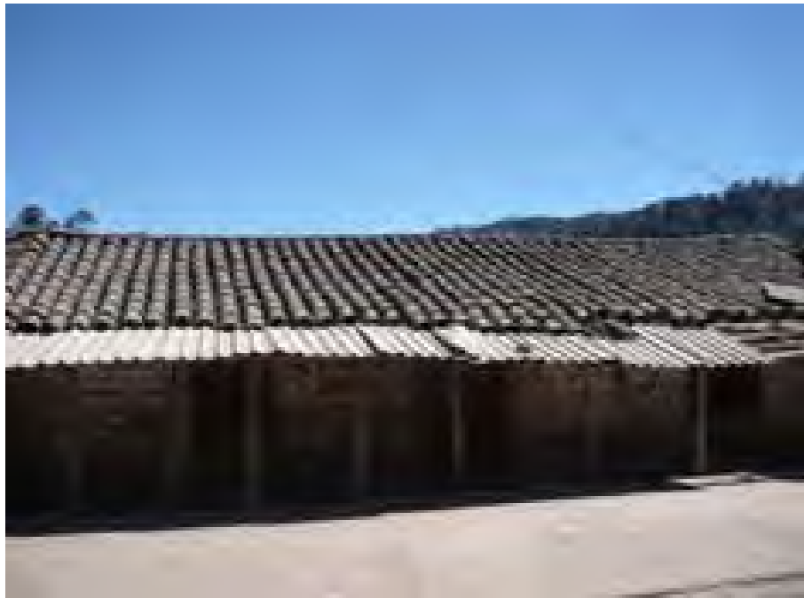
Esta vivienda tiene una altura similar a la vivienda de la página anterior con la variante de tener postes de madera en lugar de columnas de adobe.
