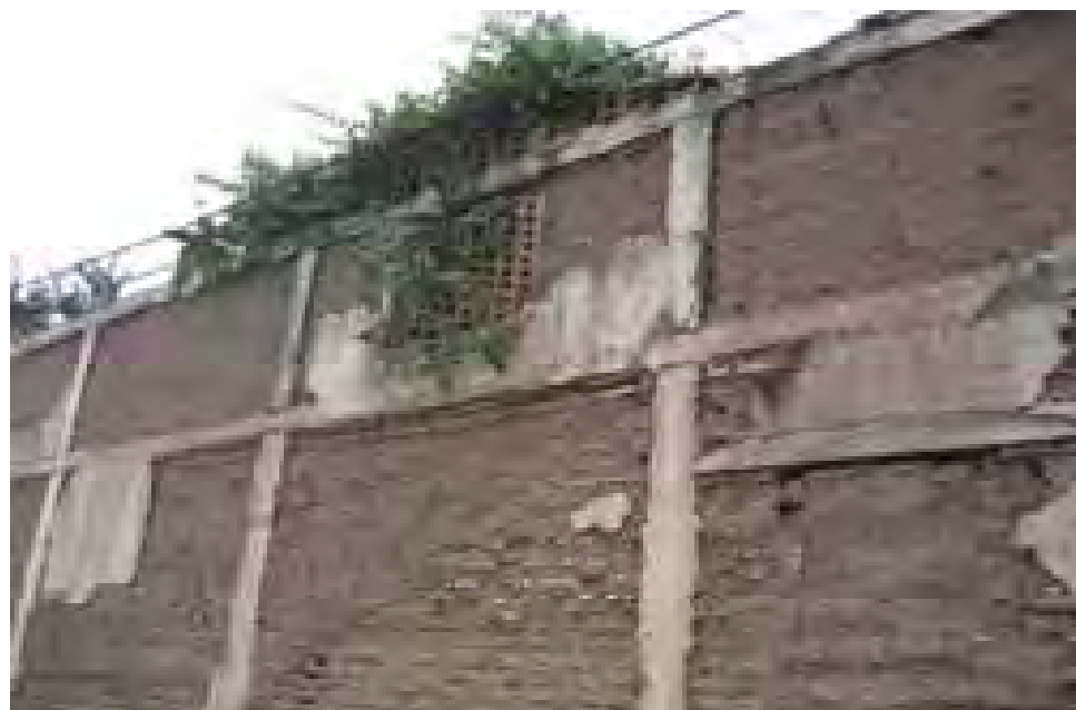
Viviendas reforzadas con cadenas y castillos de concreto armado.
