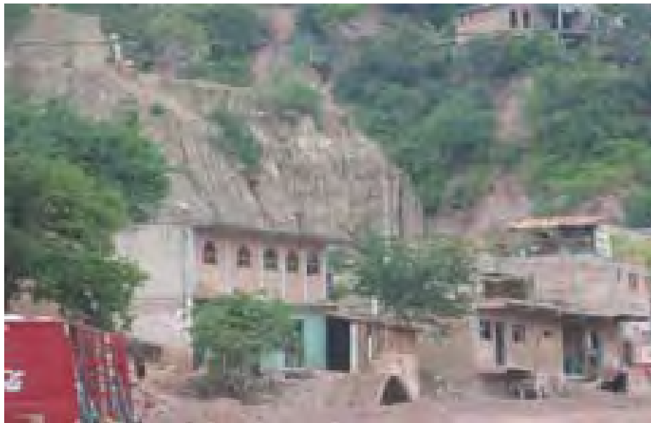
La comunidad en general se encuentra ubicada en una zona de alto riesgo además su calle principal es el cauce de un río.
