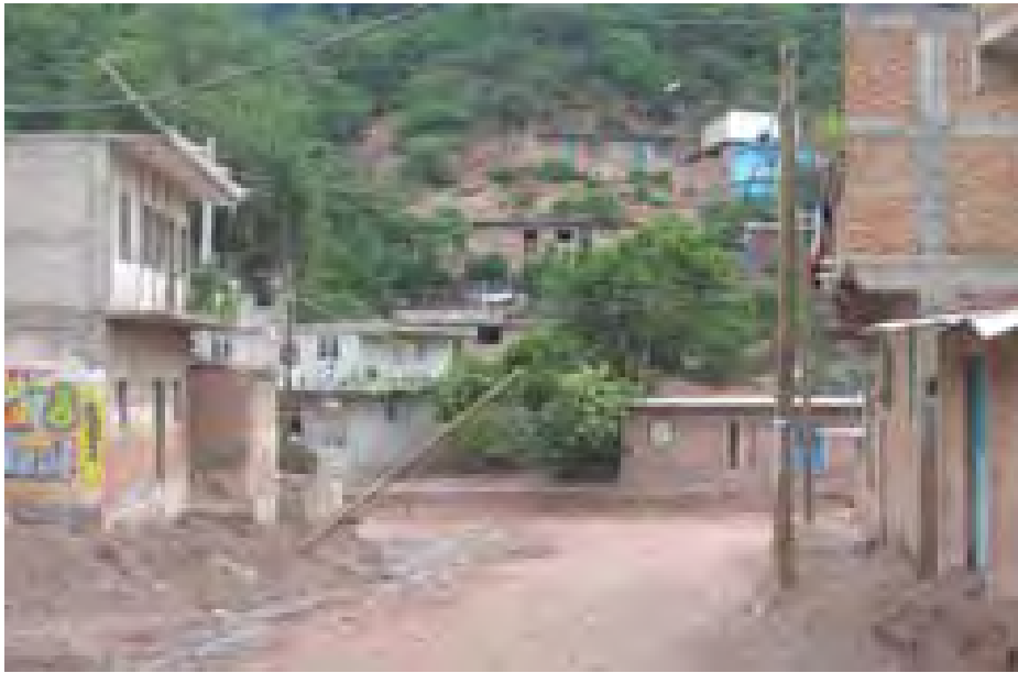
Podemos apreciar algunos daños ocasionados por el río al salirse de su cauce
