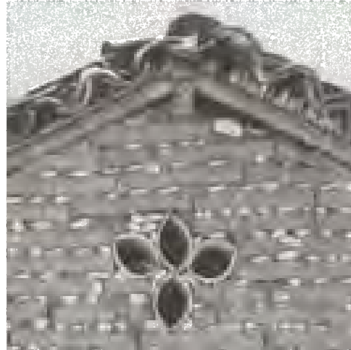
En 2009 todavía es posible encontrar algunas construcciones con detalles de este tipo.
