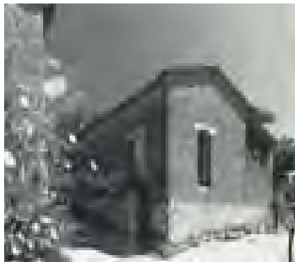
Construcción vernácula de adobe y teja en Tlapa de Comonfort.
