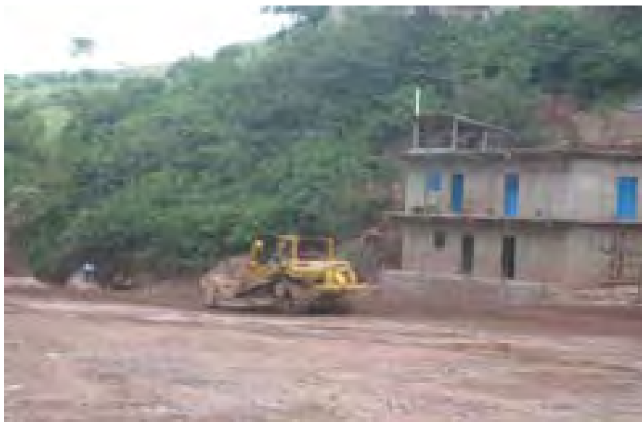
En esta imagen se ve como subió el nivel del agua del río en el mes de julio y agosto del presente año, hubo algunas personas desaparecidas y cuantiosos daños materiales. El cauce subió de nivel fuera de lo común a través de su historia.
