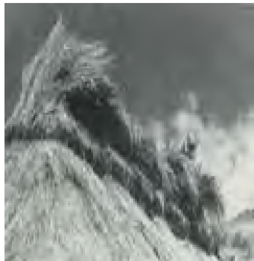
Detalles de vivienda vernácula en Zacualpa, Gro. Cuyas características se han ido extinguiendo.
