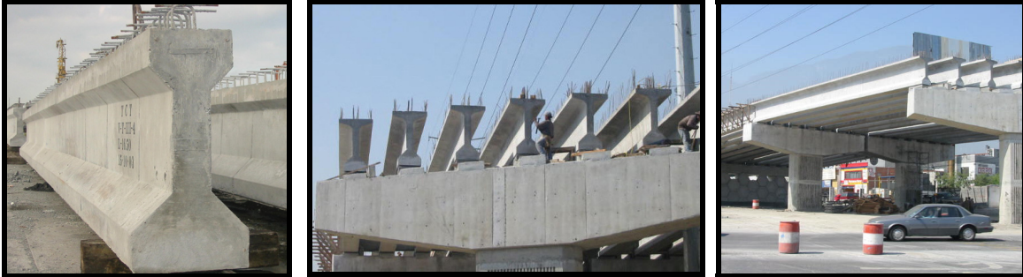
FIGURA IV.33 “TRABES PRESFORZADAS PREFABRICADAS PROPUESTAS”
