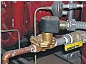
Válvula solenoide para prueba periódica automática, prueba con verdadera baja de presión en la línea.
