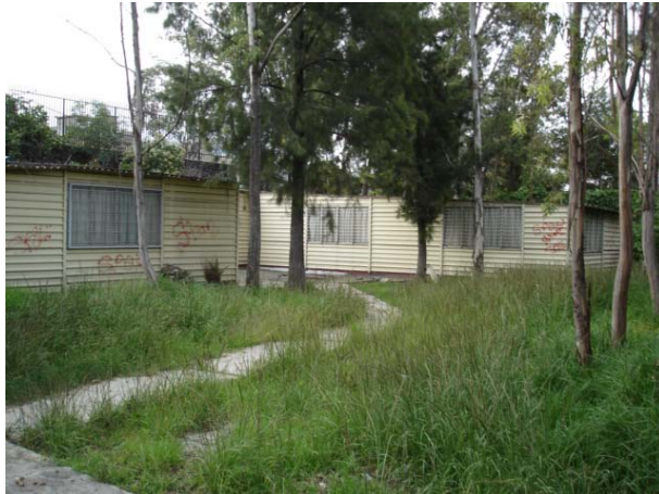
Módulos de DGRT
