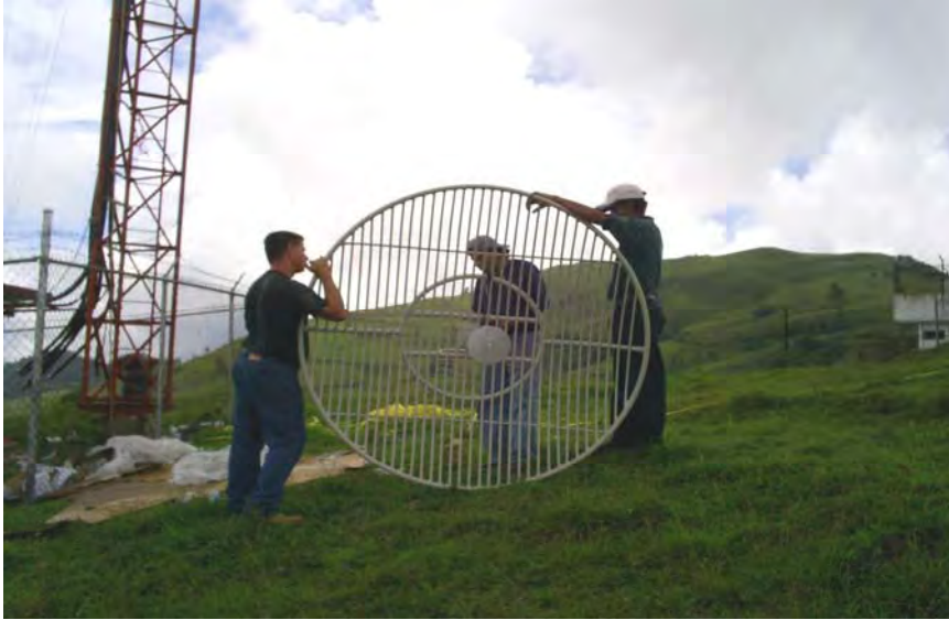
Fig. 1.2 Instalación de torres.
