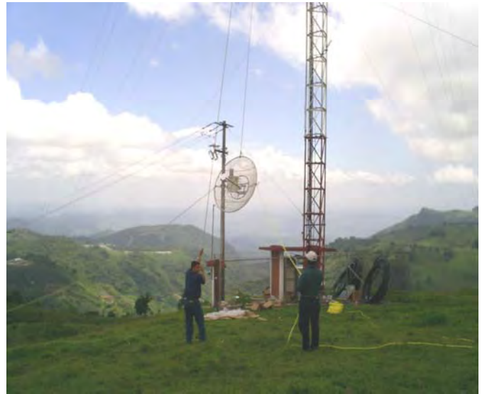
Fig. 1.4 Instalación de antenas.
