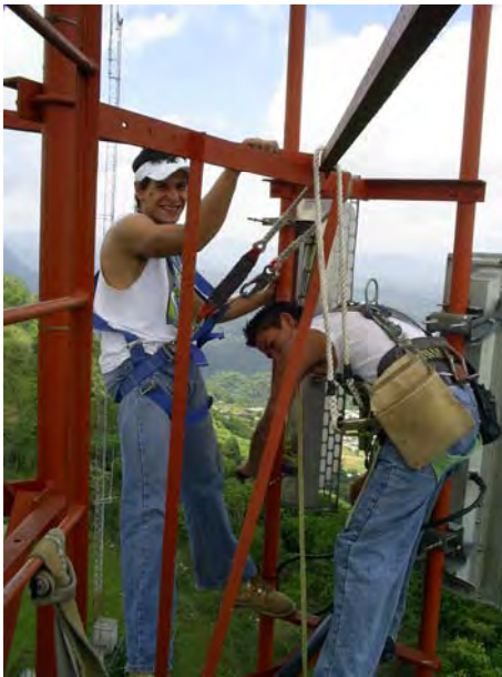
Fig. 1.3 Instalación de equipo satelital.
