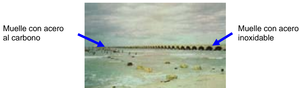
Figura 4. Muestra una foto del muelle construido con acero inoxidable y con acero al carbón
