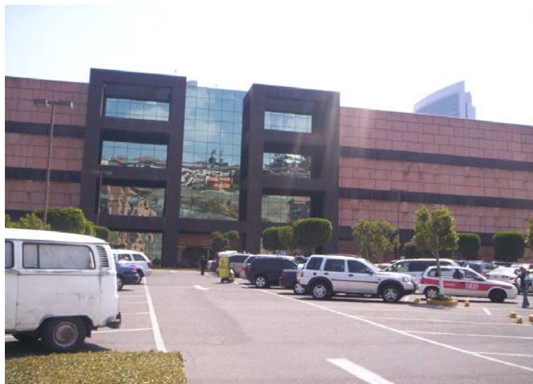
Vista de Estacionamiento Descubierto.
