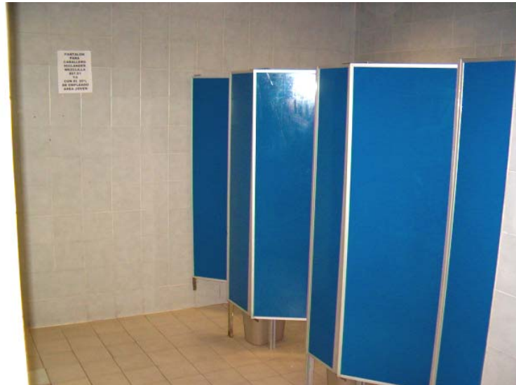
Vista panorámica sanitarios PH.
