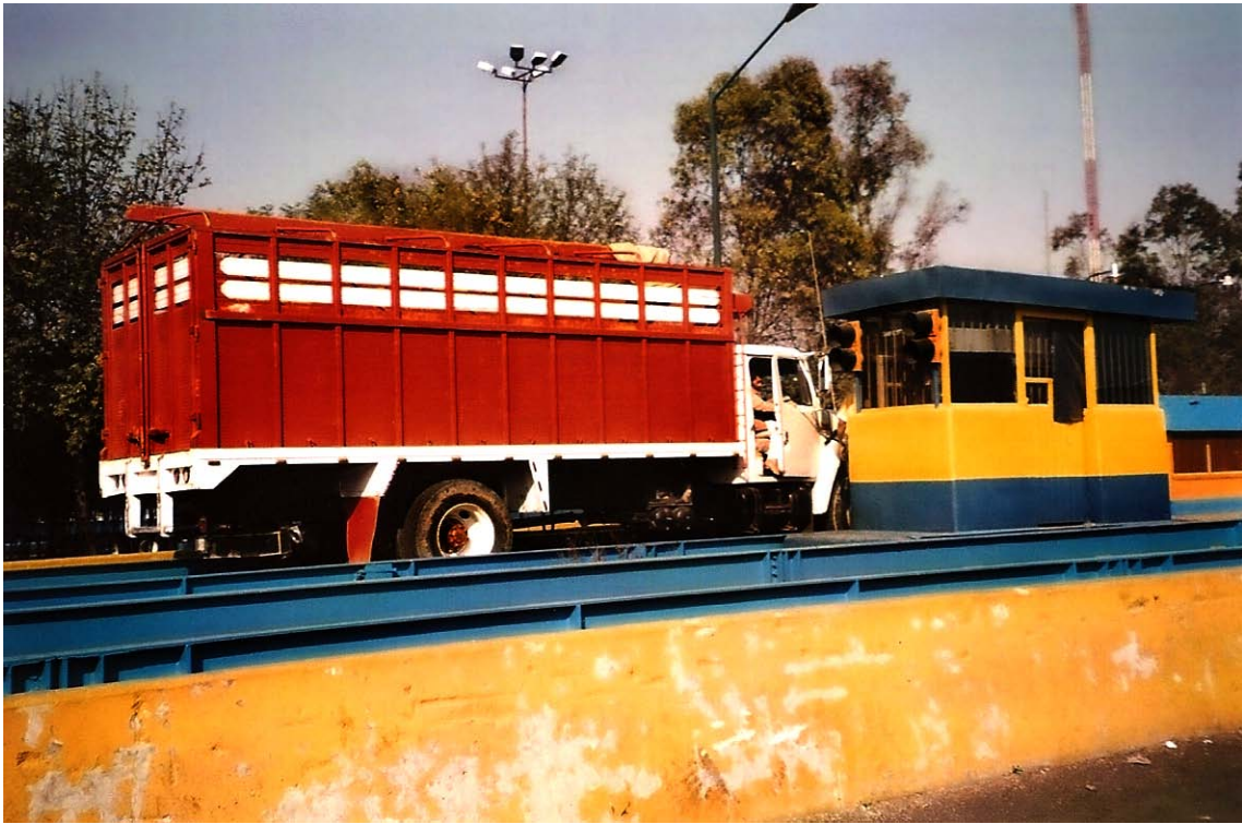
“El Servicio de Báscula consta de largas estructuras metálicas con dos viguetas azules a los costados, en donde se estacionan los camiones para pesarlos. Hay semáforos para indicar su turno.” (Pág. 78) Foto: Daniel Cisneros
