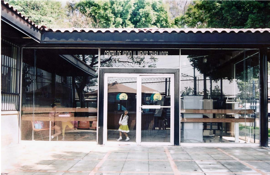
Entrada del Centro de Apoyo al Menor Trabajador de la Central de Abasto. Foto: Daniel Cisneros
