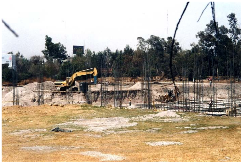
Construcción de la Plaza Central. “Los cimientos ya están terminados y los esqueletos de las columnas, múltiples varillas verticales y anillos al descubierto, sólo esperan a que se les rellene de hormigón.” (Pág. 94) Foto: Daniel Cisneros
