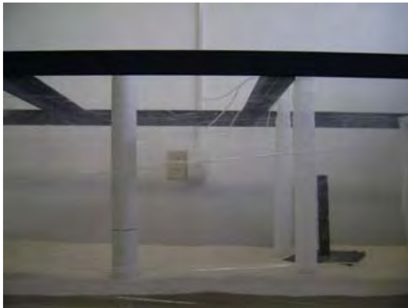
Figura 3.18 Hincado del tubo
