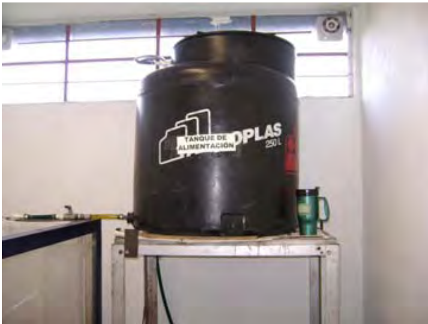
Figura 3.22 Instalación del tanque de alimentación
