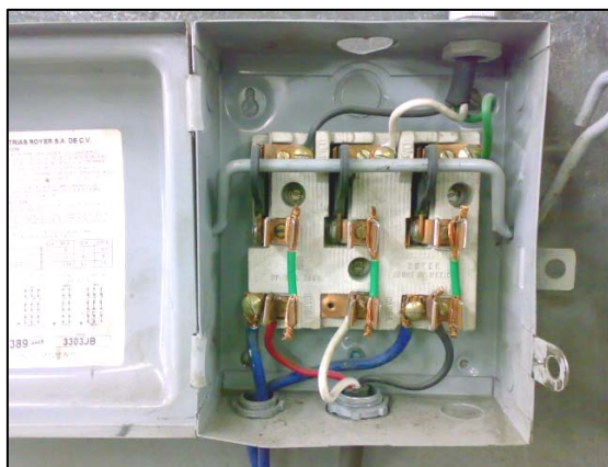
Figura 2.8A. Fusibles puenteados.
