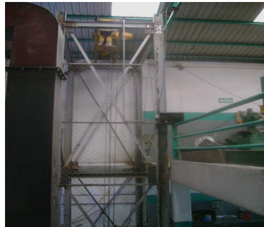
Figura 2.40. Elevador de carga. Plataforma de carga.
