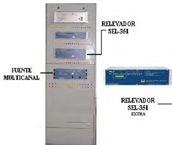
Figura 5.50 Gabinete de Protecciones y Relé Extra
