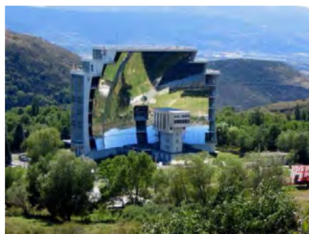
Figura 4.2. Colector solar de concentración
