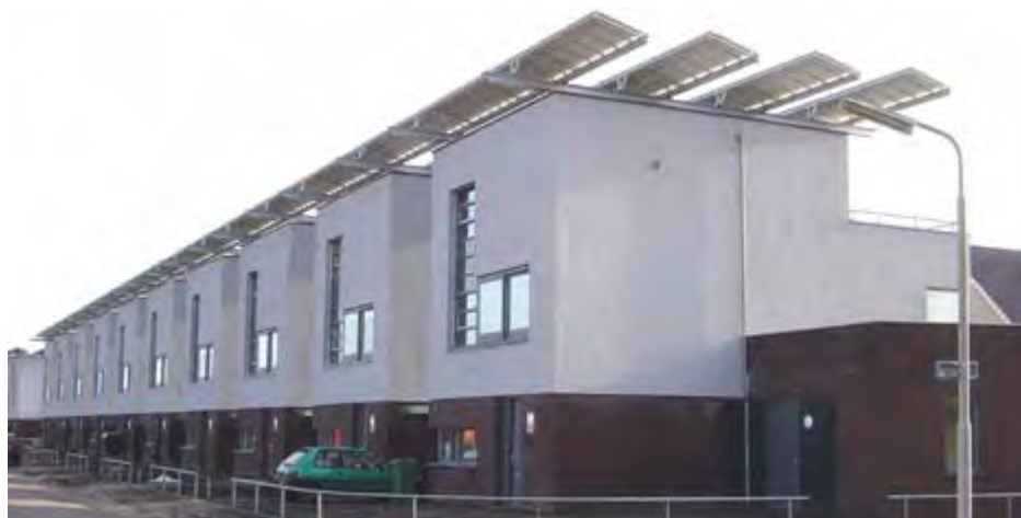
Figura 3.14 Cubiertas fotovoltaicas
