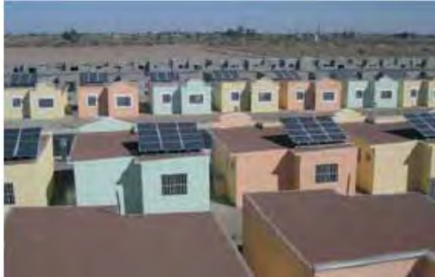
Figura 4.1. Sistemas Fotovoltaicos instalados en el desarrollo Valle de las Misiones
