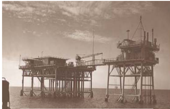
Figura 2.3. Plataforma de 8 y 6 piernas en 1947 6
