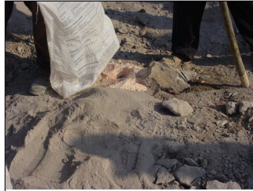
Foto 24. Barreno con Anfo antes de la preparación del taco y después del depósito del Anfo.
