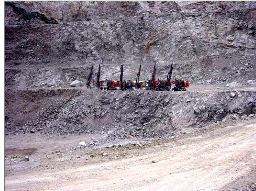
Foto 4. Equipo de perforación barrenando para un banqueo de 10 m.
