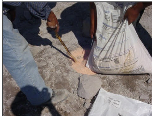
Foto 16. Deposito del Anfo con una vara, la cual también servía para medir el taco.
