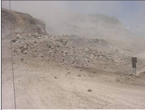
Foto 34. Voladura reciente cerca de la curva del camino que va a oficinas de Excedencias.
