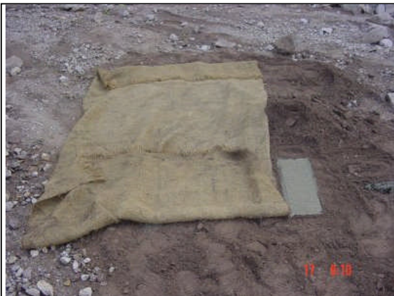
Foto 40. Colocado del cuarto molde. Se puede observar la colocación del yute.
