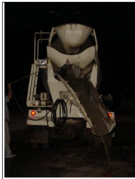
Foto 37. Toma del concreto directamente de la olla.
