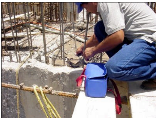
Foto 25. Colocación del sismógrafo por Dyno.
