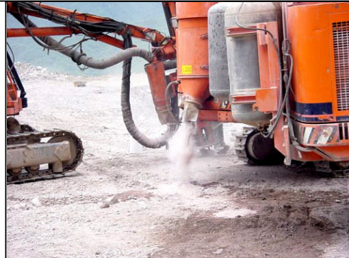
Foto 8. Polvo extraído de los hoyos perforados el cual es expulsado por detrás de la maquinaria.
