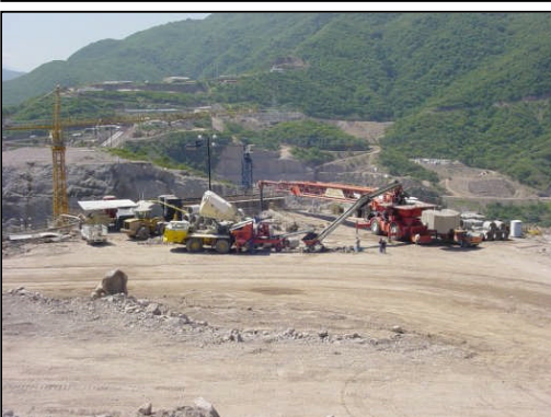
Foto 33. Colado posiblemente en Pila 1
