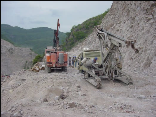
Foto 7. Dos equipos de barrenación de diferentes épocas.
