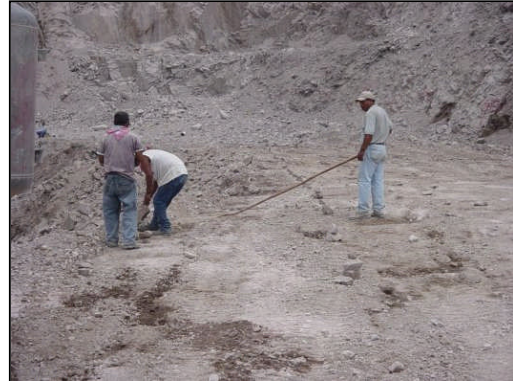
Foto 10. El encargado de la perforación con la vara que hacia la cuadrícula para la voladura, las filas de rocas que se ven son las "monas", las cuales indicaban el lugar de los barrenos.
