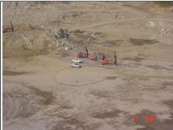
Foto 42. Lugar de la plantilla, se observan donde están perforando los hidro drill
