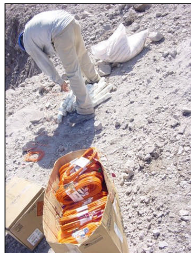
Foto 12. Preparación de los barrenos, descarga de material.
