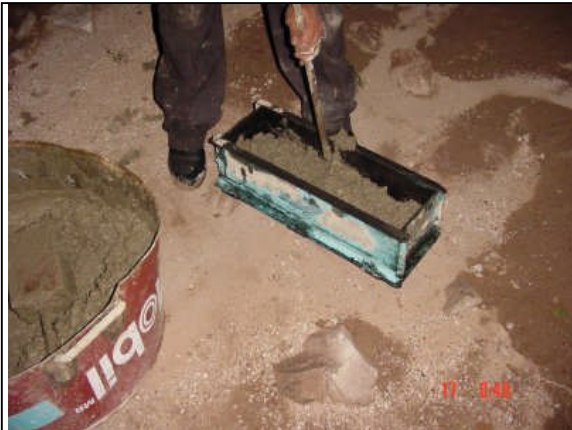
Foto 38. Penetraciones hechas en los moldes
